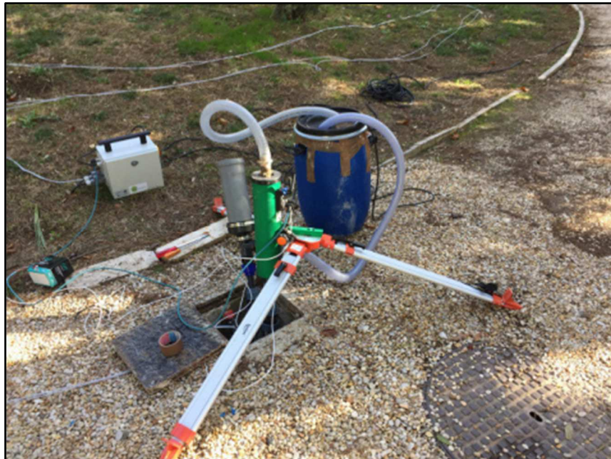
Figura 32. Equipaggiamento "Enoware Geosniff" utilizzato.
