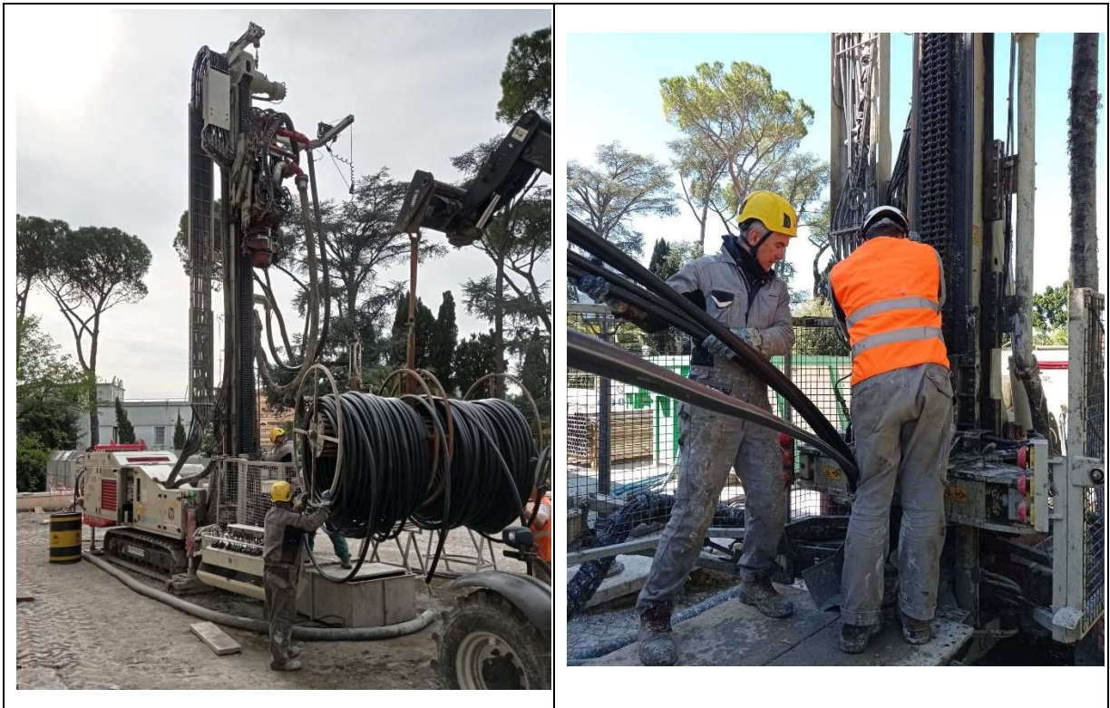
Figura 25. Operazioni di installazione della sonda geotermica.
