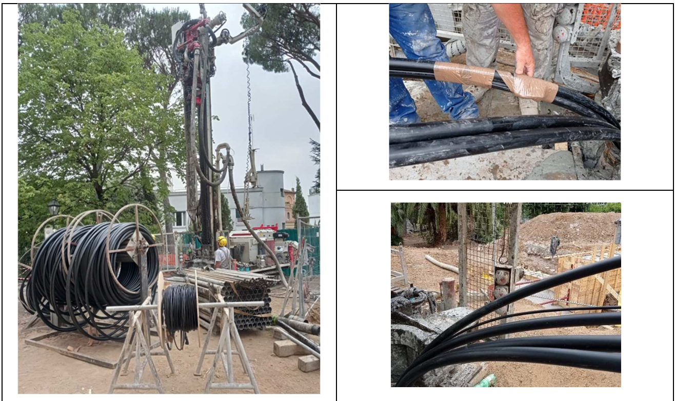
Figura 27. Fasi di installazione della fibra ottica contestualmente alla sonda geotermica.
