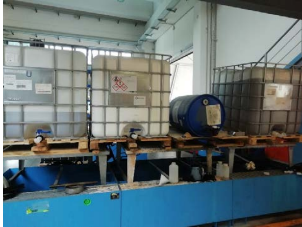
Figura 3.11 – Vista della sala mescole
