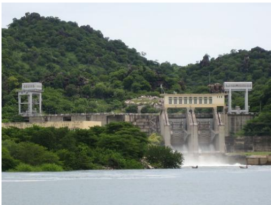
Figura 3.5 Centrale idroelettrico Lagdo
