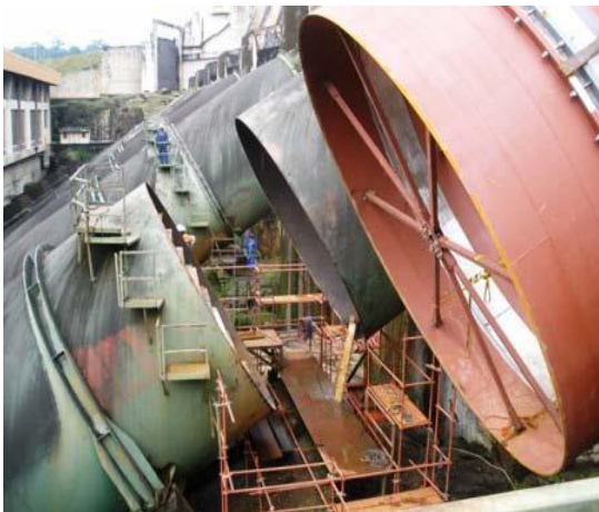
Figura 5.1 Ristrutturazione dei condotti forzati (centrale Songloulou, 2009)
