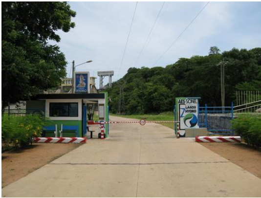
Fig 3.4 Ingresso stabilimento centrale Lagdo
