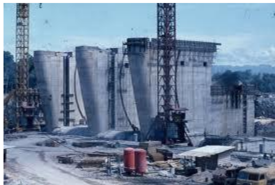
Figura 3.6 Centrale idroelettrica Song-Loulou ( in costruzione 1981)
