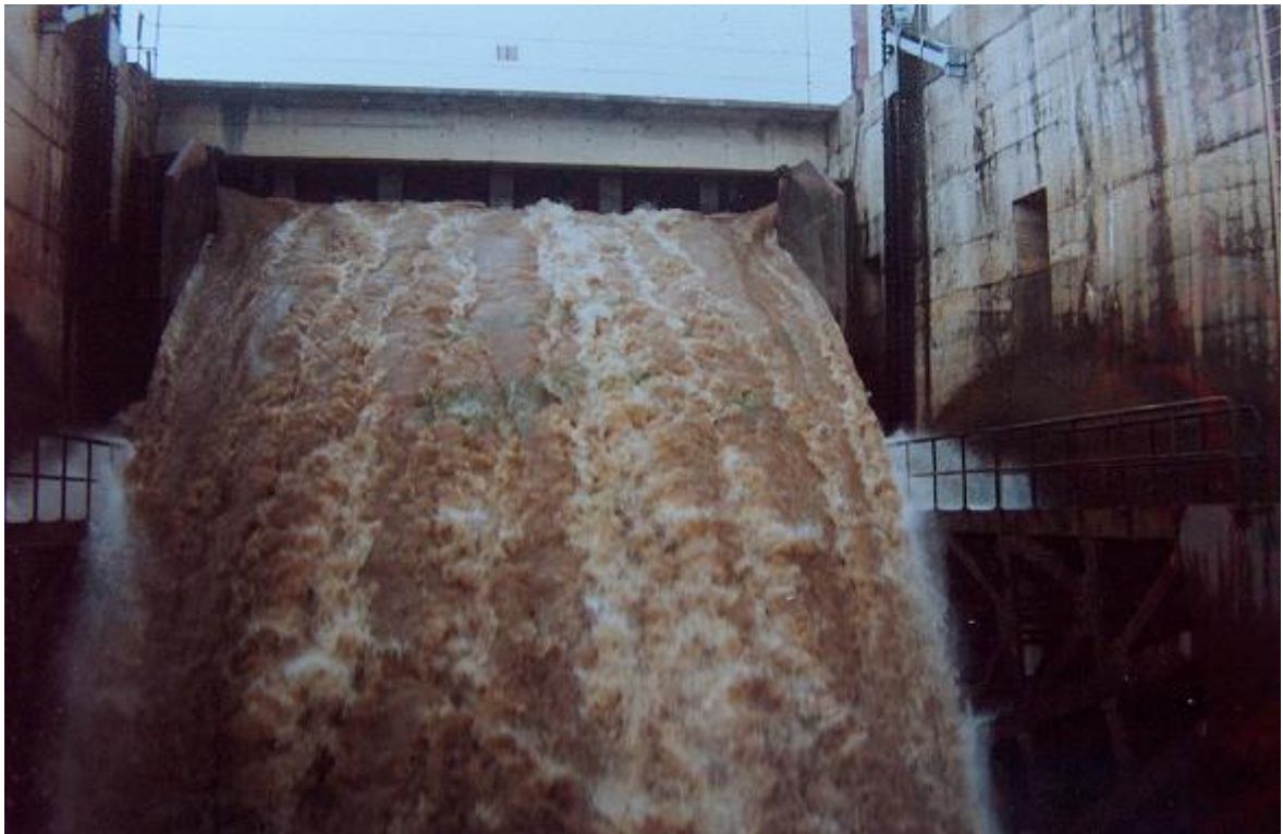
Figura 3.3 Scaricamento delle acque dalle paratie. (Edéa)
