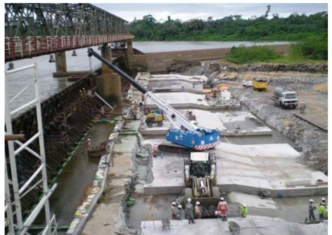
Figura 5.3 Ristrutturazione trattenute acque (centrale Songloulou, 2009)
