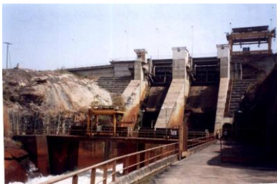
Figura 3.11 Diga riserva Mape.
