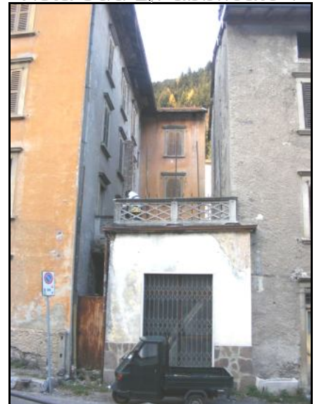
Vista Sud B/Fabbricato 1
