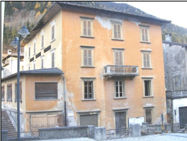
Vista Sud A/Fabbricato 1
