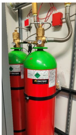
Figura 7.3.3 Bombole di gas Novec
