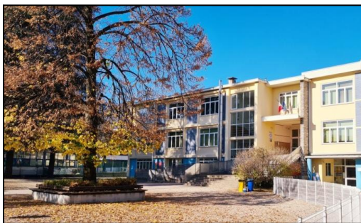
Figura 2 – Entrata al primo piano della scuola primaria A. Rosmini
