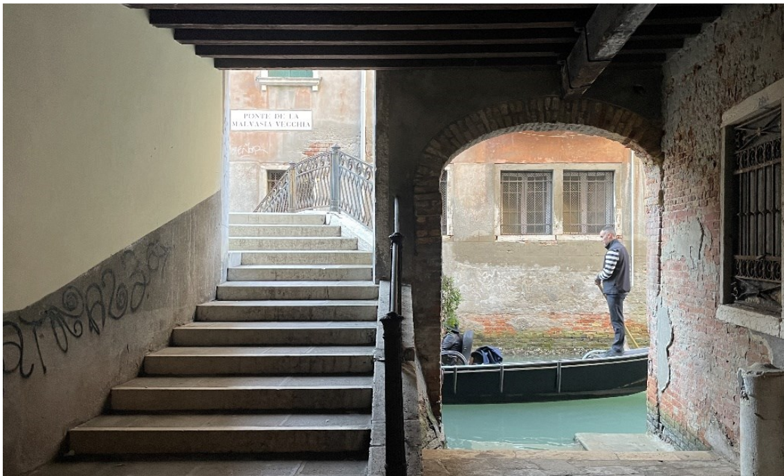
Figura 4 Ponte de la Malvasia Vecchia visto dall'omonimo sottoportego (foto di C. Zaramella).
