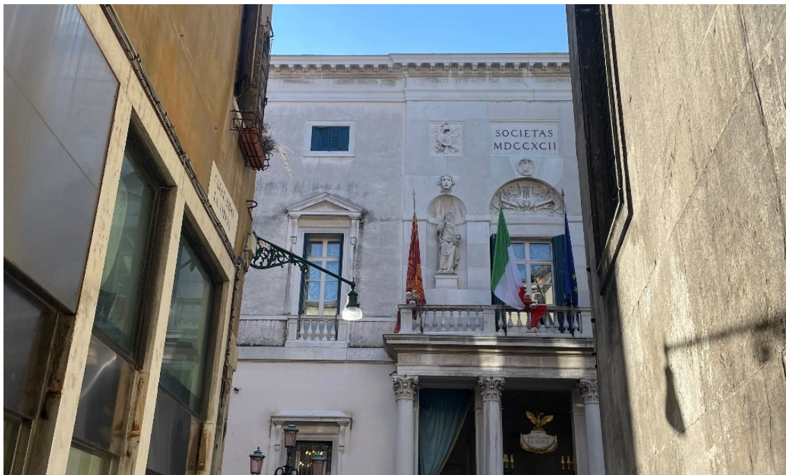
Figura 9 Vista di campo San Fantin da calle Drio la Chiesa (foto di C. Zaramella).
