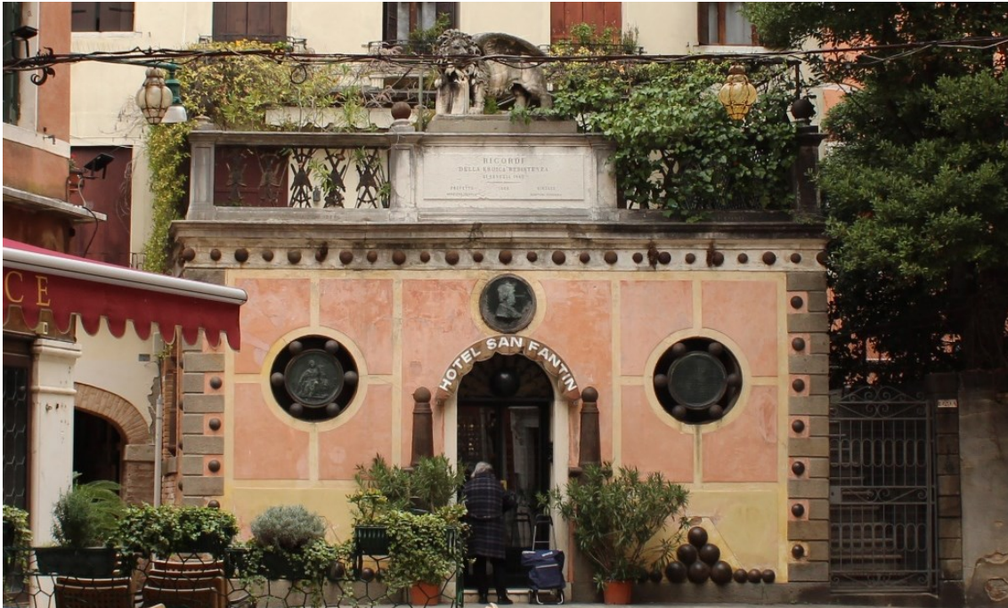
Figura 5 Hotel San Fantin edificato nel 1869 (foto di C. Zaramella).
