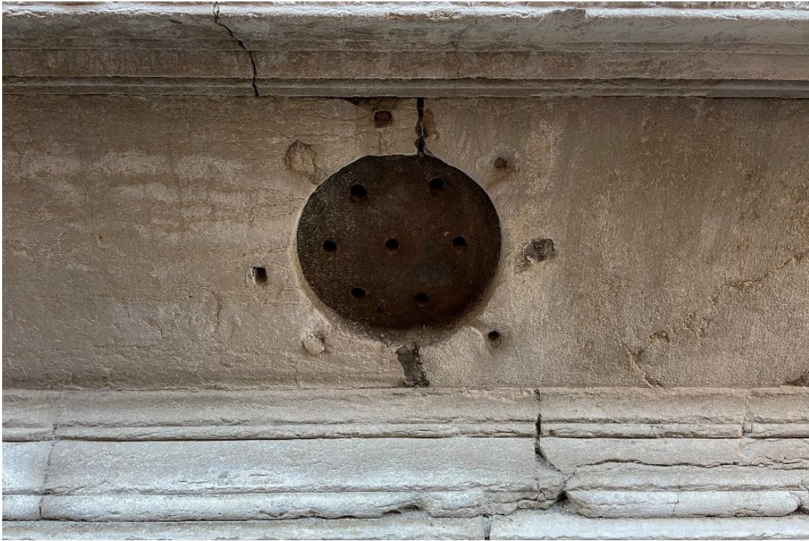
Figura 44 Oculo di aerazione della cripta (foto di C. Zaramella).
