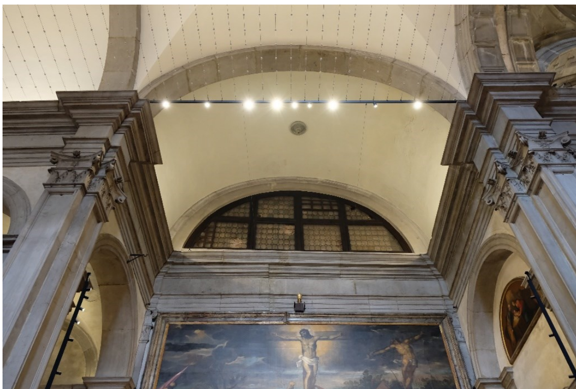
Figura 37 Finestra termale tamponata in corrispondenza dell'edificio addossato alla chiesa (foto di C. Zaramella).
