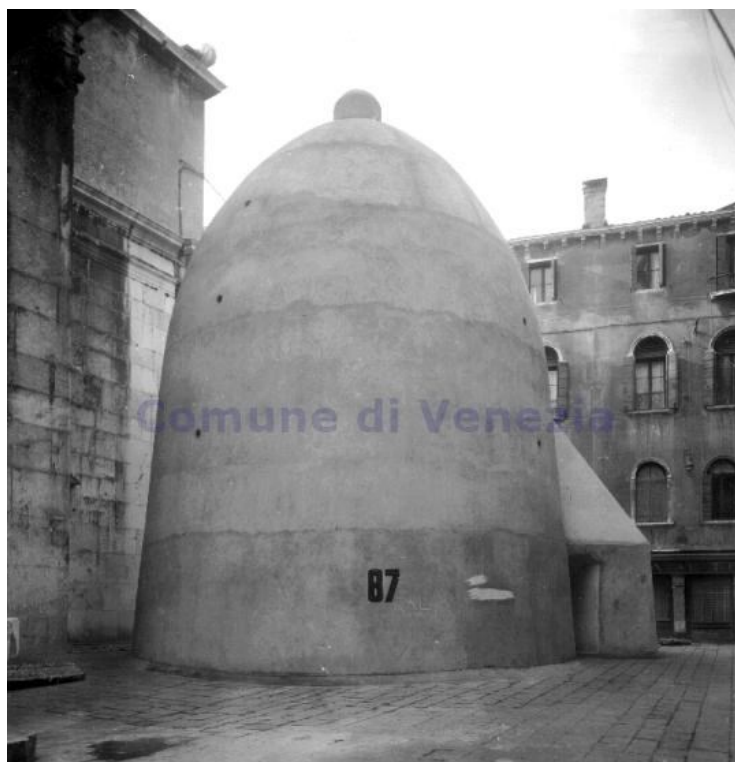
Figura 26 Bunker in campo San Fantin ( www.albumdivenezia.it ).
