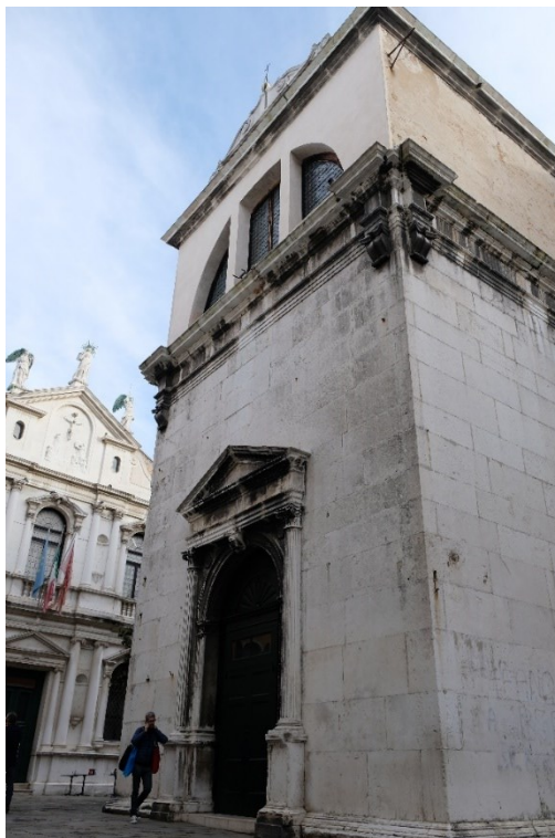
Figura 31 Vista esterna della chiesa (foto di C. Zaramella).
