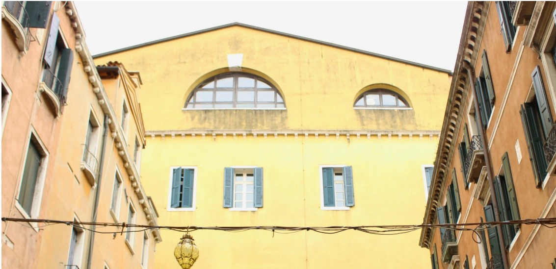
Figura 28 Cornice che delimita la porzione di muro aggiunto in occasione della ricostruzione del 1996 (foto di C. Zaramella).
