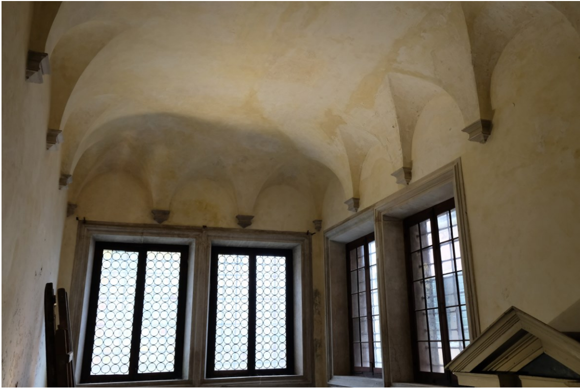
Figura 40 Volta a schifo della sagrestia (foto di C. Zaramella).
