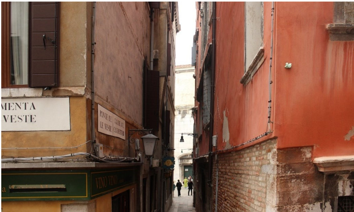
Figura 10 Vista da ponte de le Veste verso calle del Caffettier (foto di C. Zaramella).
