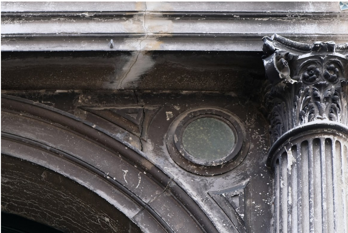
Figura 63 Tondo in serpentino verde sul portone d'ingresso (foto di C. Zaramella).
