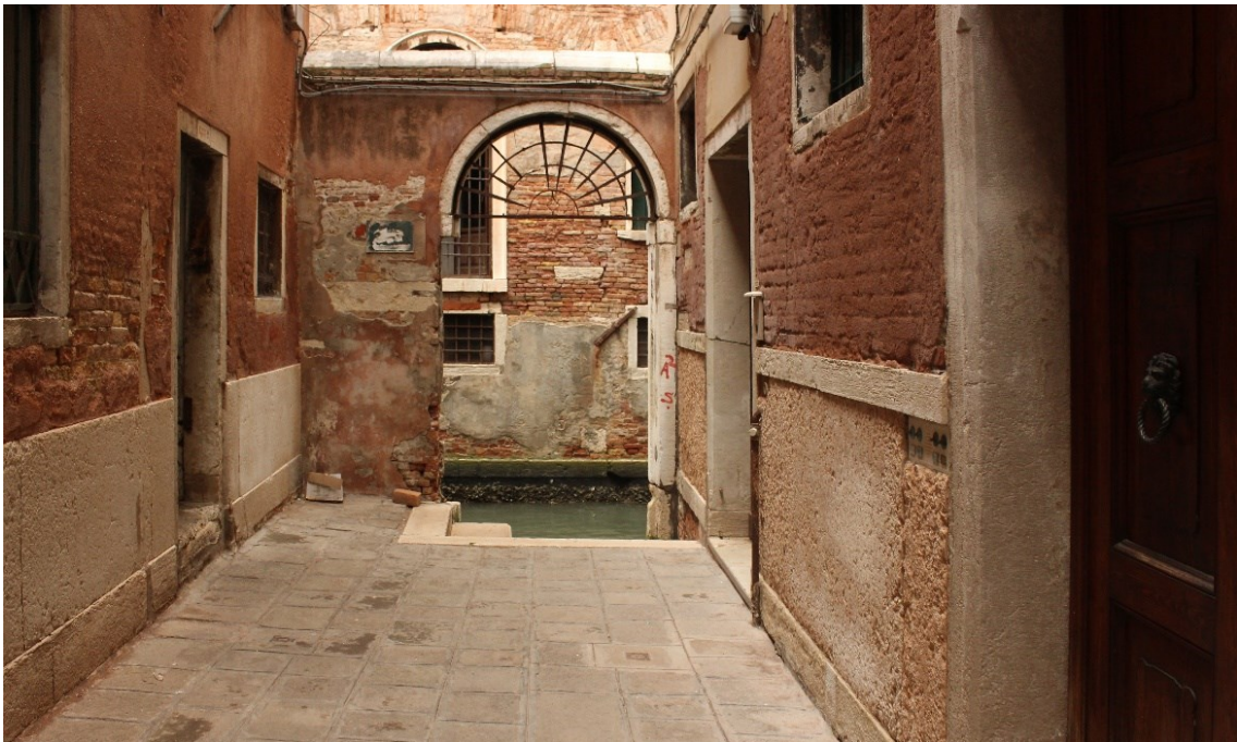
Figura 12 Porta d'acqua su calle Minelli (foto di C. Zaramella).
