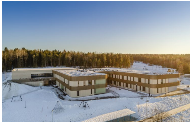
Figura 1: scuola primaria di Torvbråten, in Norvegia (Infobuildenergia, 2021)
