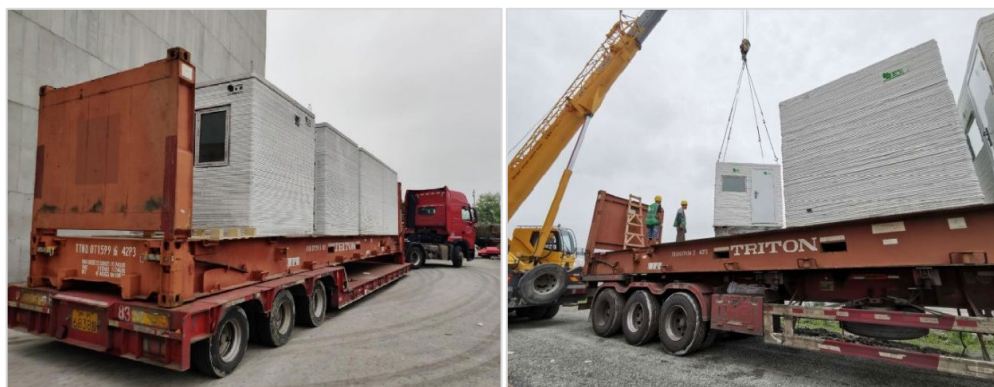
FIG. 41 – Trasporto delle camere di isolamento
