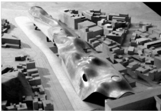
FIG. 8 – Illa de Blanes : tetto a doppia curvatura
