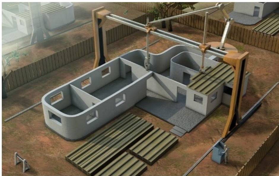
FIG. 15 – Concrete Printing . Esempio concettuale
