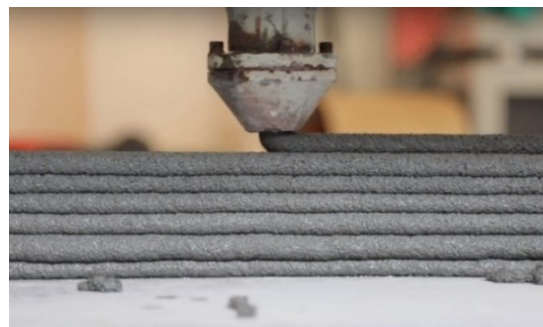
FIG. 14 – Contour Crafting: strati di materiale cementizio estruso
