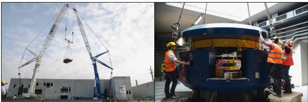
Figura 1. 11 Fasi di installazione del ciclotrone presso i L.N.L. (Maggio 2015)
