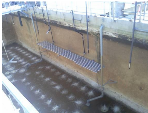
Figura 25. Scambiatore di calore e pale meccaniche
