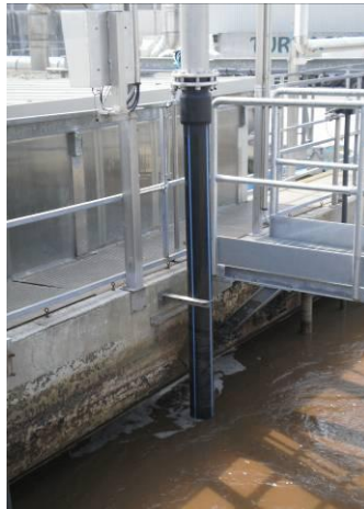
Figura 26. Tubo di alimentazione
