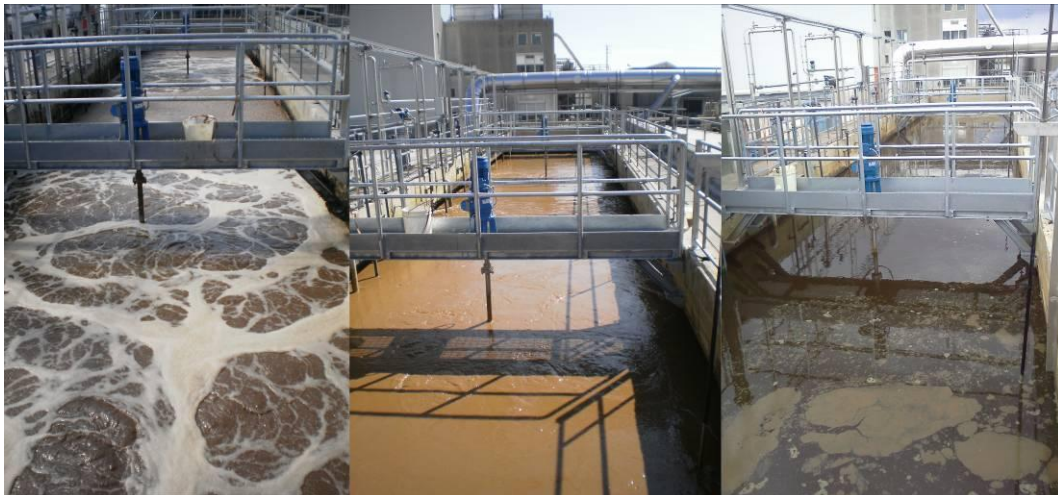
Figura 27. Fasi dell'SBR (nitrificazione, denitrificazione e chiarificazione).
