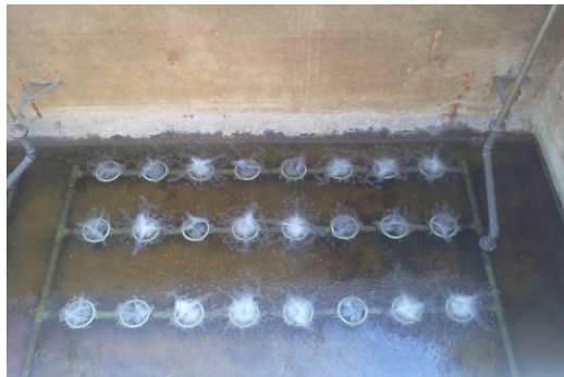
Figura 24. Piattelli insufflatori di ossigeno.
