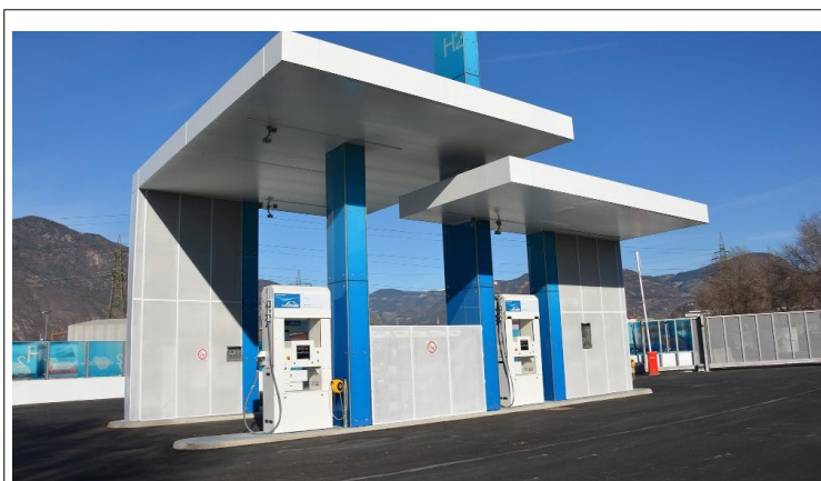
Figura 3.2.2: Distributore idrogeno di Bolzano (BZ)
