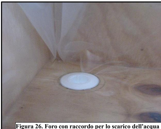
Figura 26. Foro con raccordo per lo scarico dell'acqua
