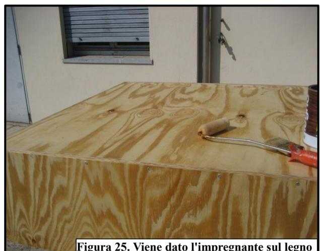
Figura 25. Viene dato l'impregnante sul legno
