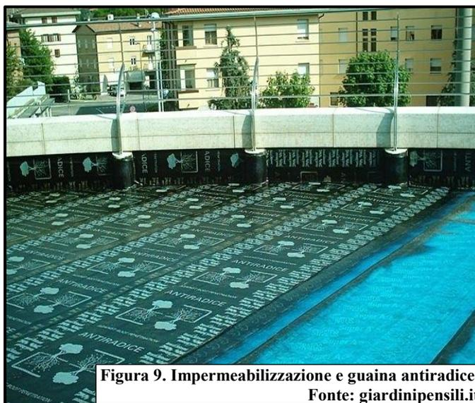
Figura 9. Impermeabilizzazione e guaina antiradice.
