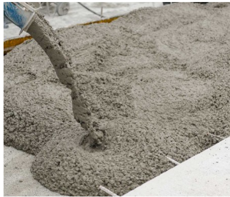
Figura 1.2: Colata di calcestruzzo
