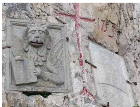
Figura 1.6 – Le targhe di confine Tirolo-Veneto, oggi visibili sotto le cime del Ra Gusela.
