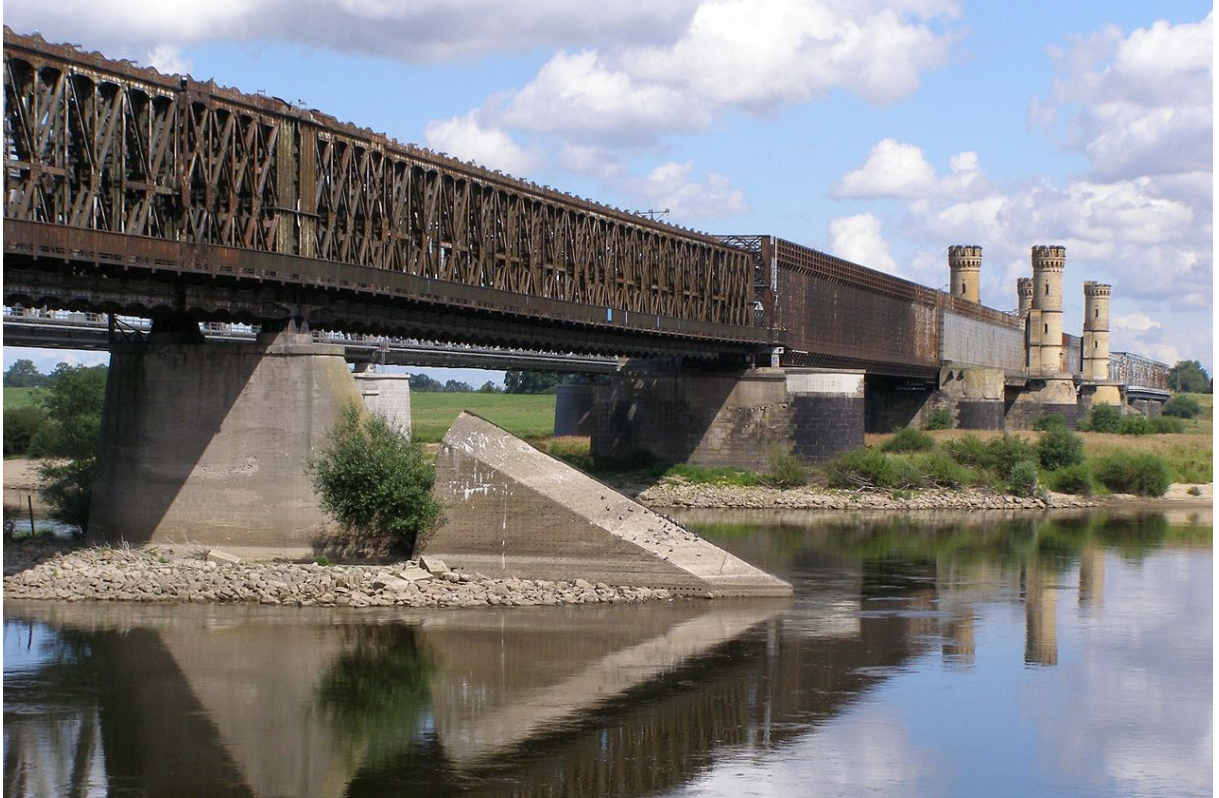
Figura 3.1.4: ponte in Tczew (Polonia), avente l'elemento rompighiaccio a ridosso della pila. (Riportata in: https://en.wikipedia.org/wiki/Starling_(structure)#/media/File:Tczew_most_wieczyczki_2.jpg )
