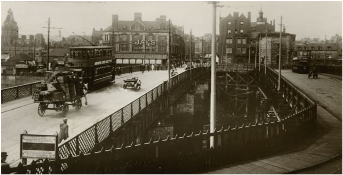
Figura 3.2.3.7: Veduta del nuovo ponte di Newport e della passerella pedonale temporanea costruita in legno. (Riportato in: http://www.newportpast.com/bridges/town_bridge/index.php ).
