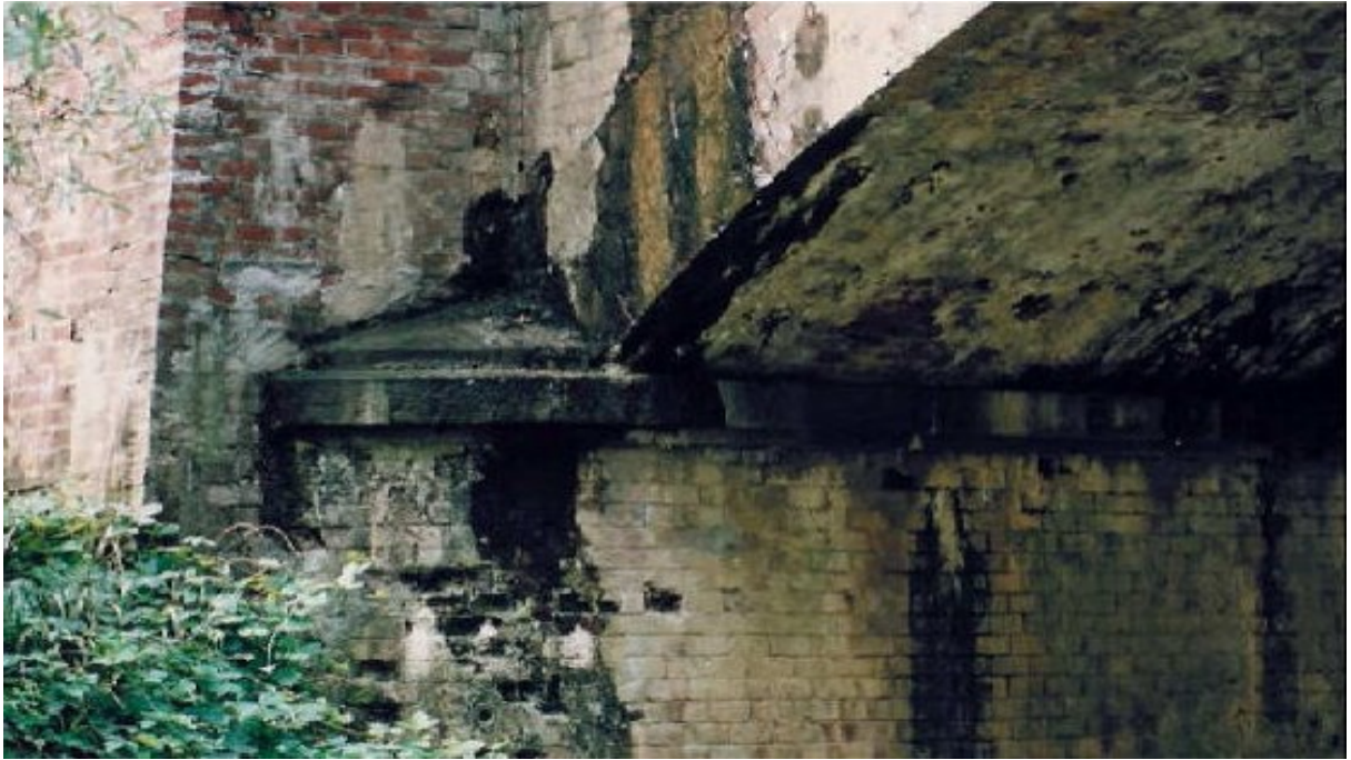
Figura 3.2.1.4: Spalla con mezzi rostri, Ponte Maletta – linea Trofarello-Cunco. (Fonte: Solazzo, 2016)
