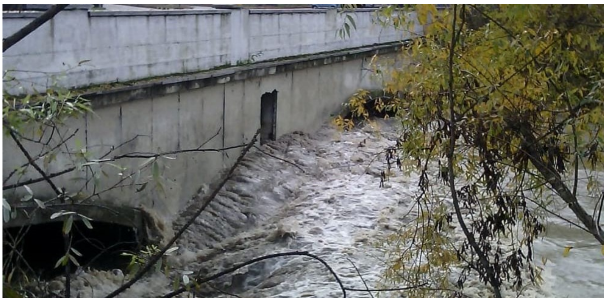
Figura 2.1: Esempio di spinta della corrente sulle pile massicce, che costituiscono impedimenti al libero deflusso. (Riportata in: https://www.torinotoday.it/cronaca/ponte-corso-svizzera-pericolante.html ).
