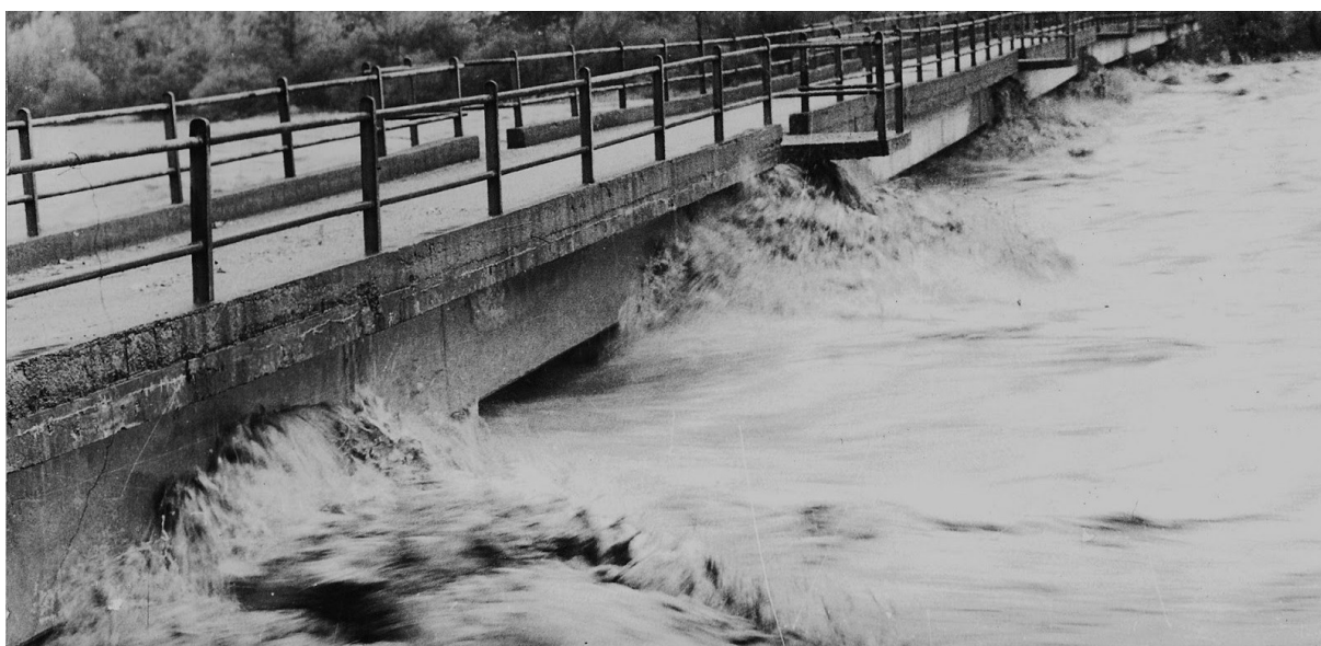
Figura 2.2.1: Esempio di rialzo idraulico su una passerella pedonale durante la piena. (Riportata in https://www.danielesaisi.com/2012/01/non-tutti-sanno-che-ponti-sul-serchio.html ).
