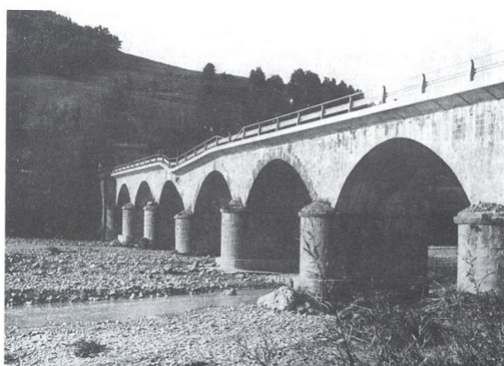
Figura 2.1.3: Esempi di crolli di attraversamenti dovuti a fenomeni di erosione localizzata alla base di una pila (Brath, 2007).
