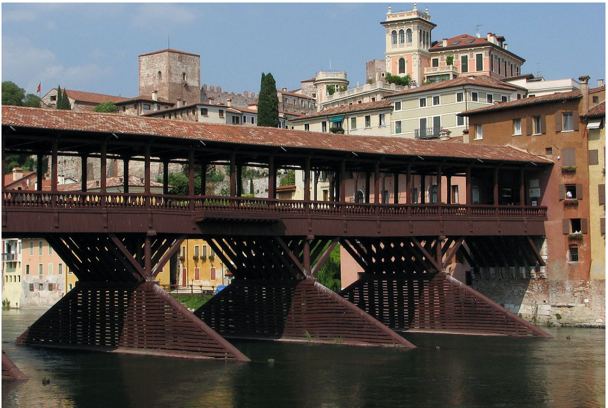
Figura 3.2.3.5: Veduta dei frangicorrente del ponte di Bassano del Grappa. (Riportato in: https://it.wikipedia.org/wiki/Ponte_Vecchio_(Bassano_del_Grappa)#/media/File:Ponte_degli_Alpini_Bassano_del_Grappa_2007.jpg ).
