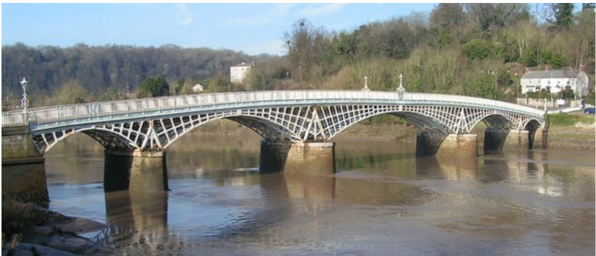
Figura 3.1.3: Ponte l'Old Wye Bridge (Chepstow), soggetto a maree che richiedono una simmetria per via del flusso influenzato dalla marea. (Riportata in: https://en.wikipedia.org/wiki/Old_Wye_Bridge,_Chepstow#/media/File:Bridge_over_Wye_-_geograph.org.uk_-_682946.jpg )
