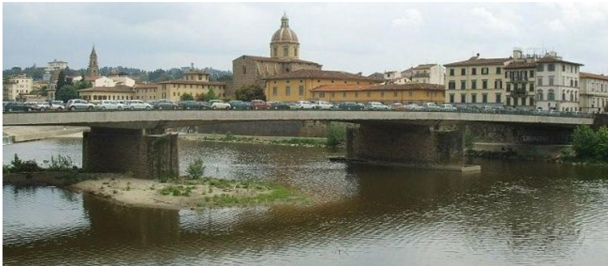
Figura 2.2.4: Esempio di pila posizionata in una golena. (Riportato in: https://zero.eu/it/luoghi/6109-ponte-milvio-2,roma/ ).
