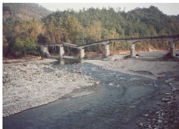
Figura 2.1.3: Esempi di crolli di attraversamenti dovuti a fenomeni di erosione localizzata alla base di una pila (Brath, 2007).
