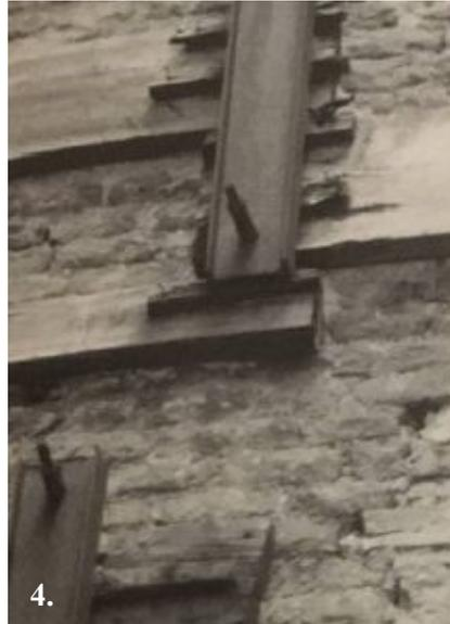
**Fig. 4. Prospetto N. Particolare della muratura in blocchetti di tufo (da Bianchi L. 1998).**
