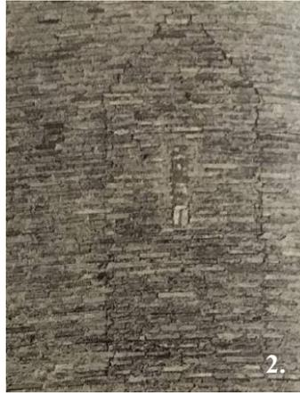
**Fig. 2. Apertura tamponata sul prospetto SE.**
