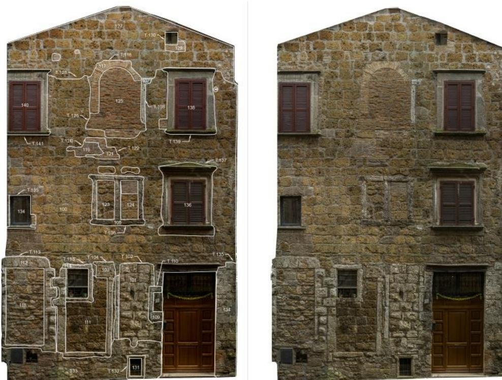
**Fig. 1 e 2. Prospetto con lettura stratigrafica.**
