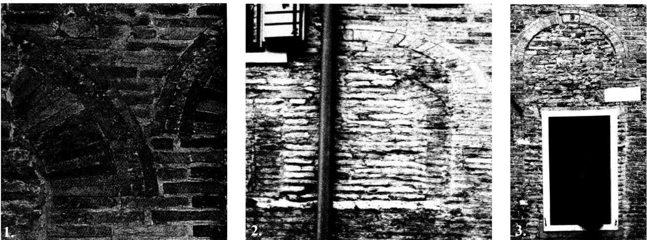
**Fig. 1,2,3.** Prospetto W, bardellone; prospetto S, finestra con bardellone; prospetto W, apertura a tutto sesto.
