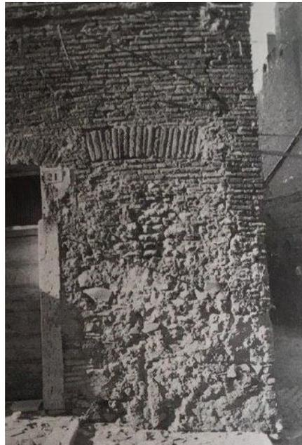
**Fig. 4. Particolare di apertura tamponata.**
