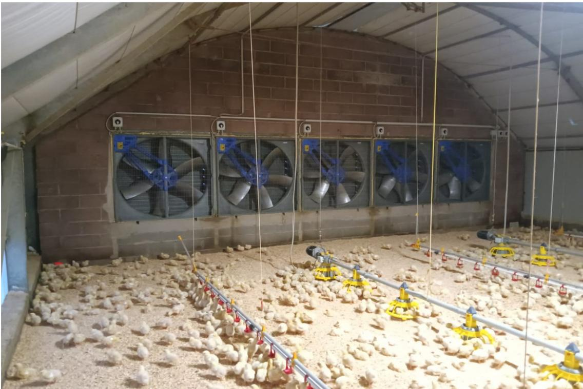
Fig. 26. Ventilatori posizionati sulla parete di fondo di ogni capannone.
