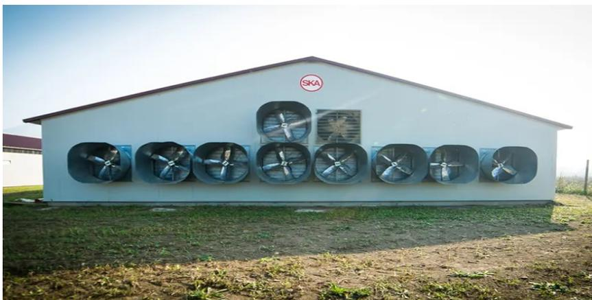
Figura 11. Parete posteriore di un capannone avicolo con una lunga serie di ventilatori estrattori (SKA Poultry Equipment).
