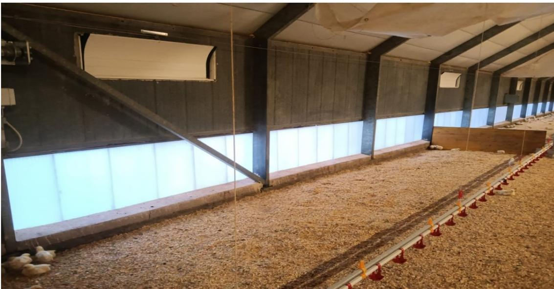
Fig. 19. Pannello in policarbonato trasparente che permette l'entrata della luce solare
