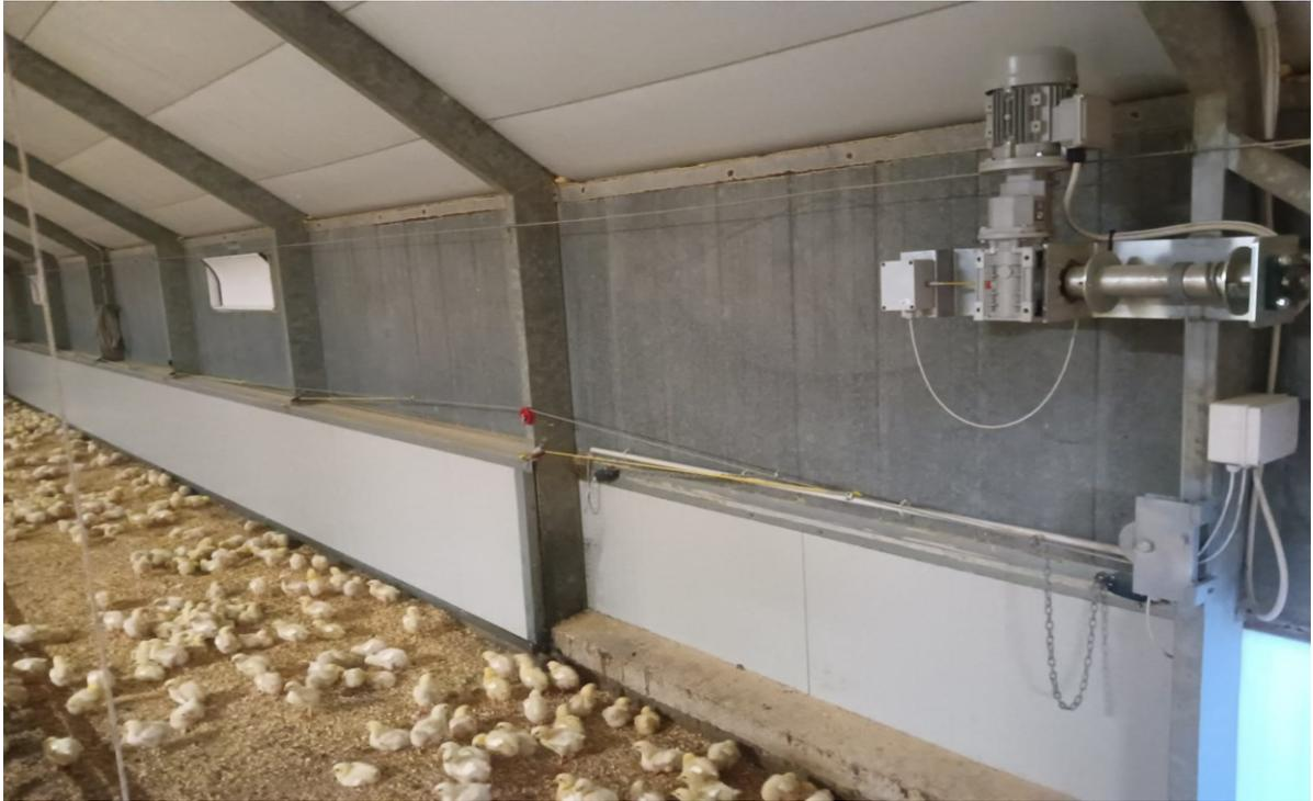
Fig. 28. Particolare di una delle due finestre estive presenti all'interno di ogni capannone.
