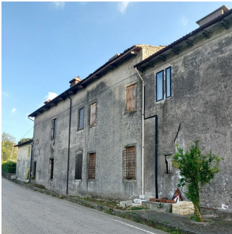
Fig.3.11 Facciata nord di Villa Arnaldi
