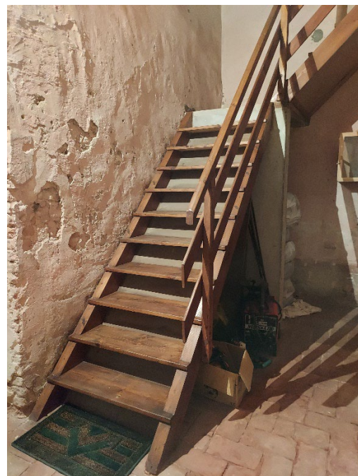
Fig.5.25 Rampa di scale in legno nella sala 4.
