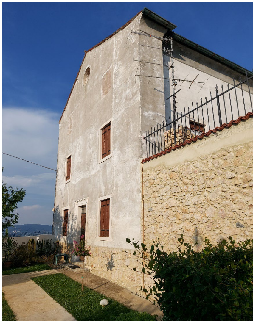
Fig.3.22 Facciata ovest della Chiesa di San Nicola
