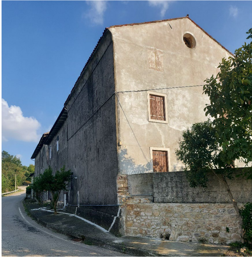
Fig.3.23 Facciata nord della Chiesa di San Nicola
