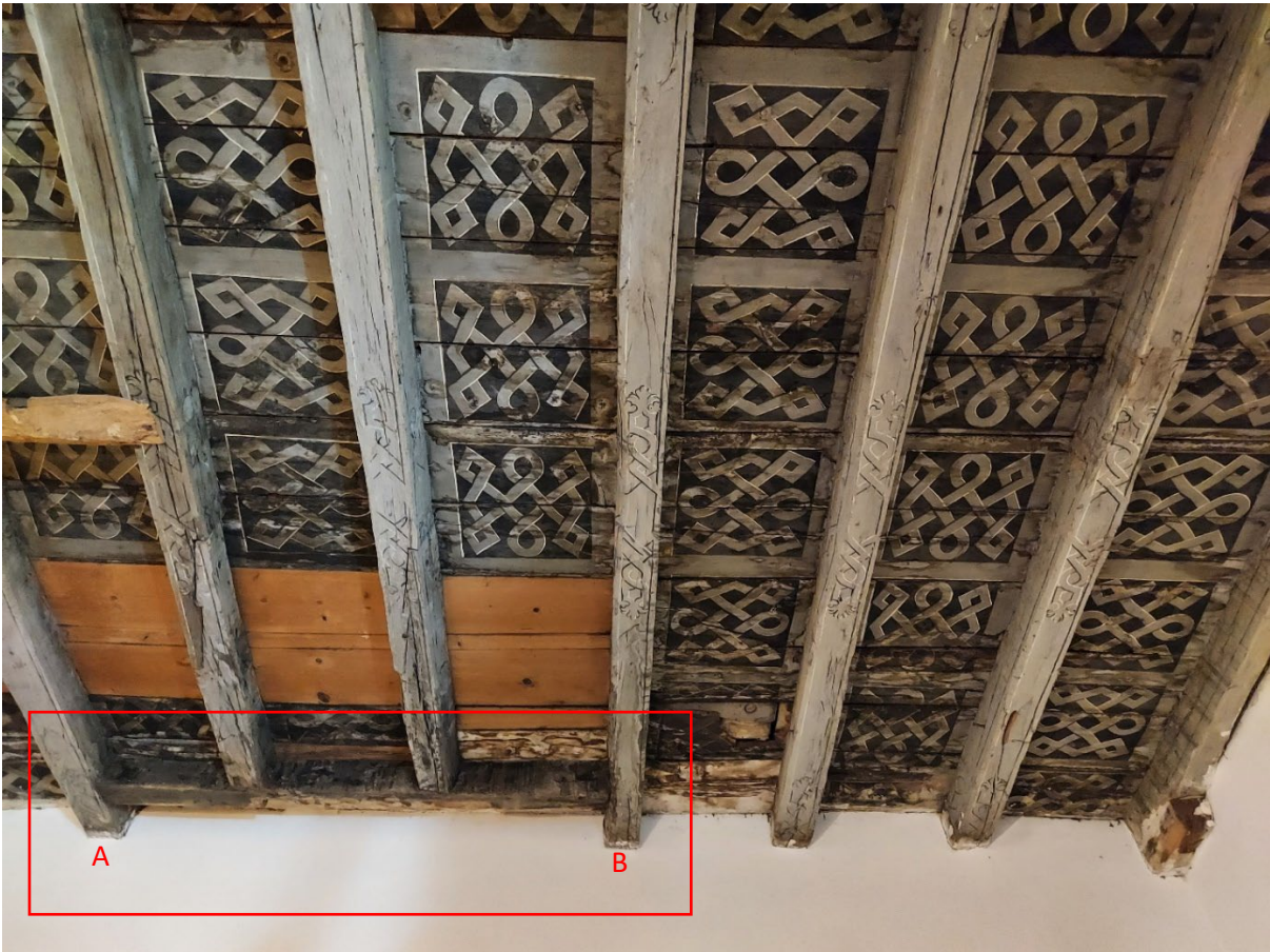
Fig.5.44 Dettaglio del solaio della sala 11 (S3). Si nota il bilanciino, riquadrato di rosso, innestato sulle travi A e B.
