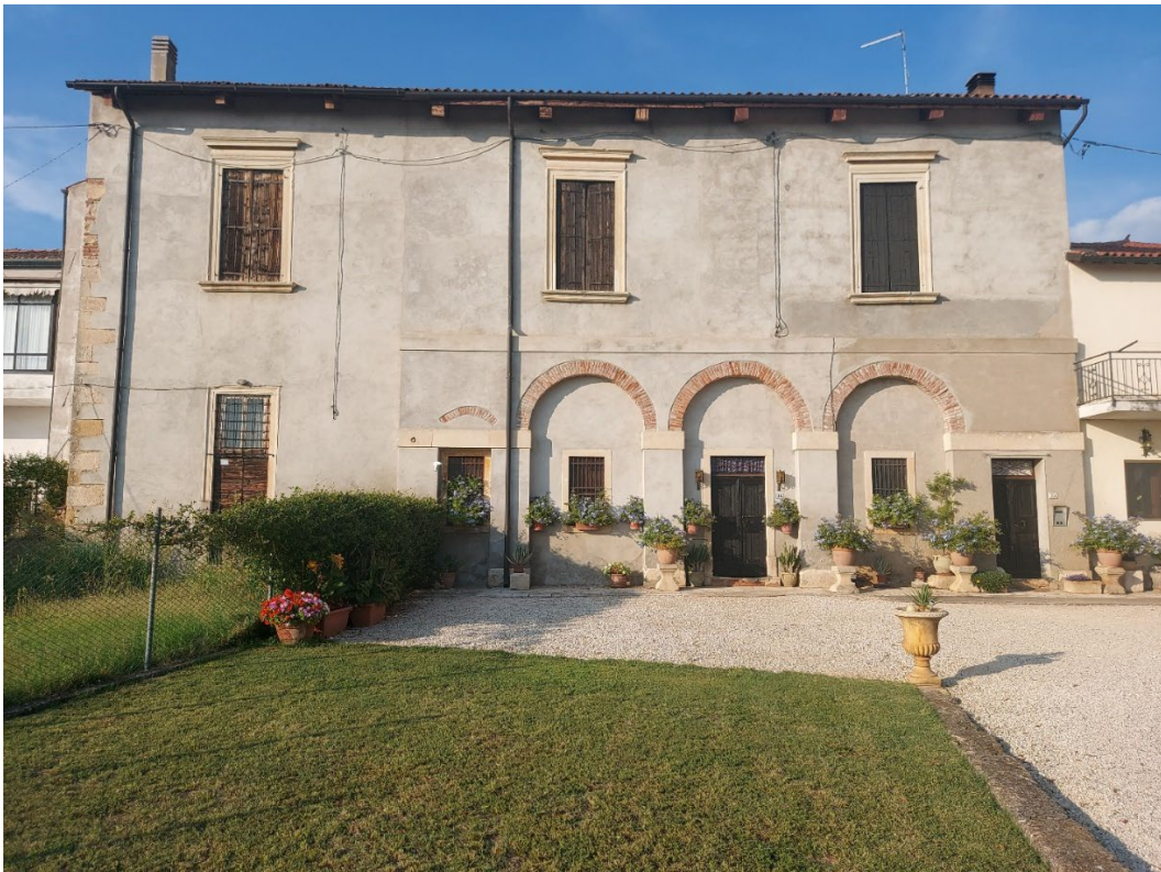
Fig.3.4 Facciata meridionale di Villa Arnaldi
