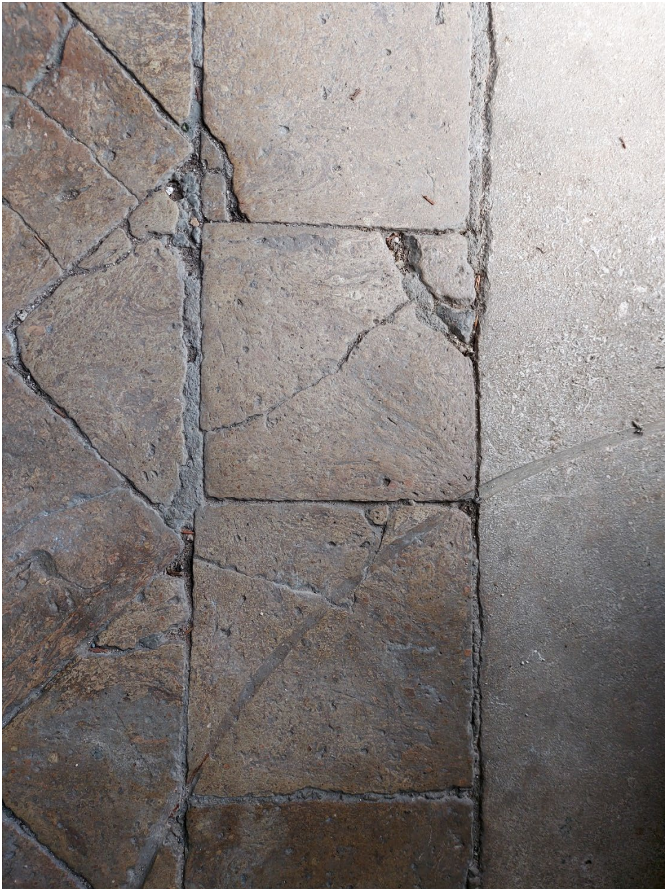
Fig.5.29 Dettaglio del pavimento della ex loggia (P1). Il pavimento è in laterizio con piastrelle quadrate di lato pari a 21 cm. A destra c'è la soglia della porta di ingresso alla sala 1b, in pietra di Vicenza.
