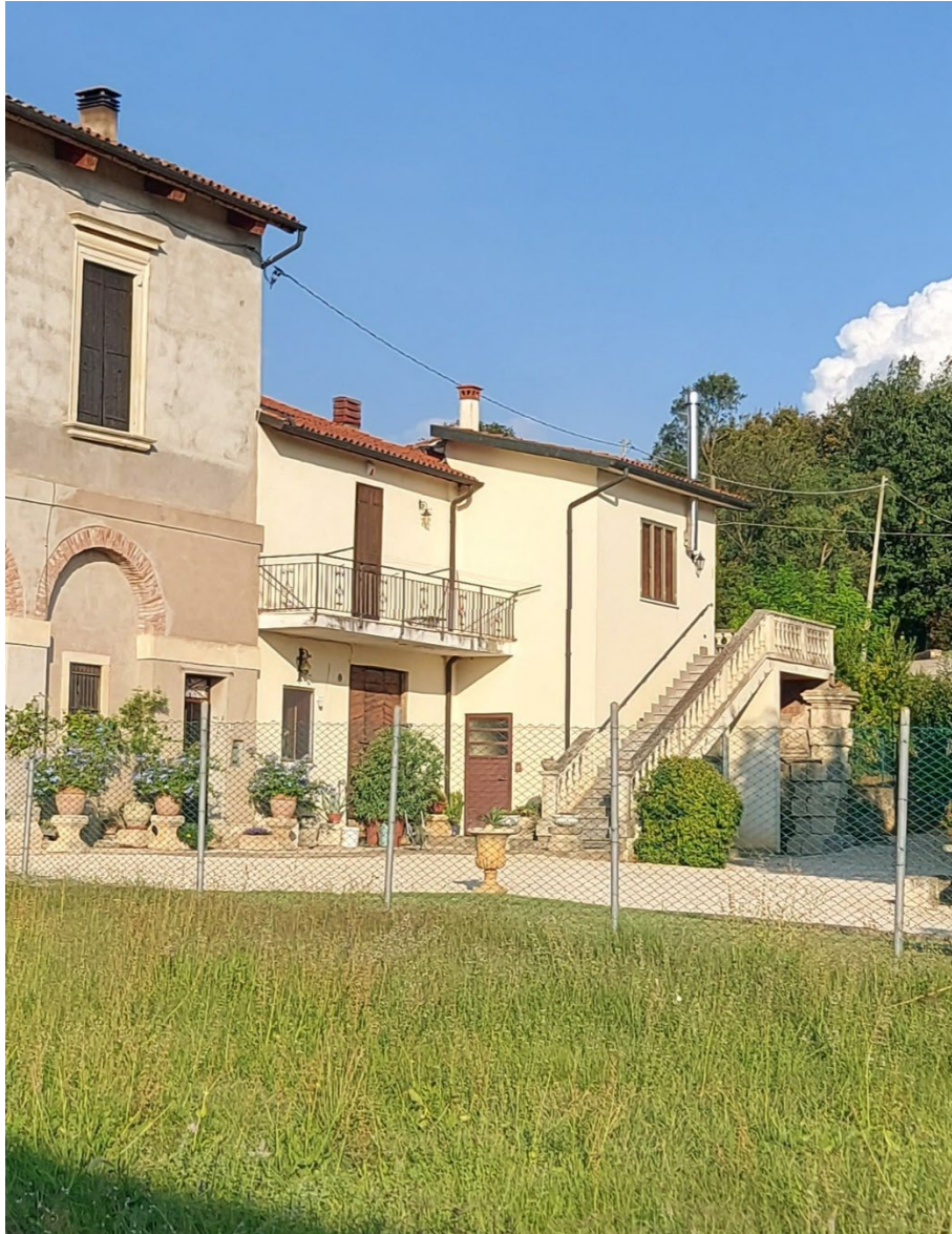
Fig.3.9 Facciata dell'edificio "moderno" adiacente a Villa Arnaldi
