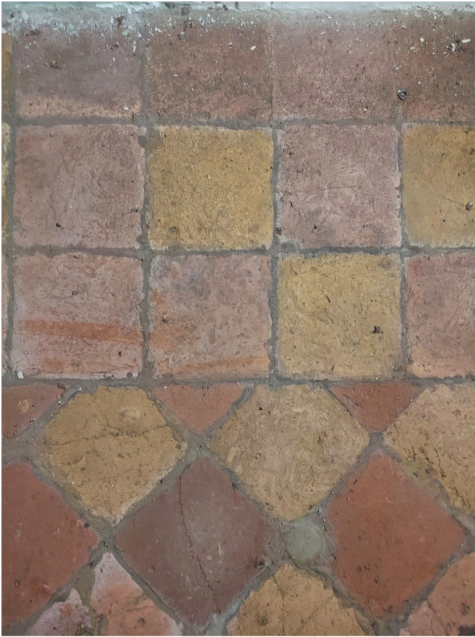
Fig.5.30 Dettaglio del pavimento della sala 3 (P2). Il pavimento è in laterizio con piastrelle quadrate di lato pari a 21 cm.
