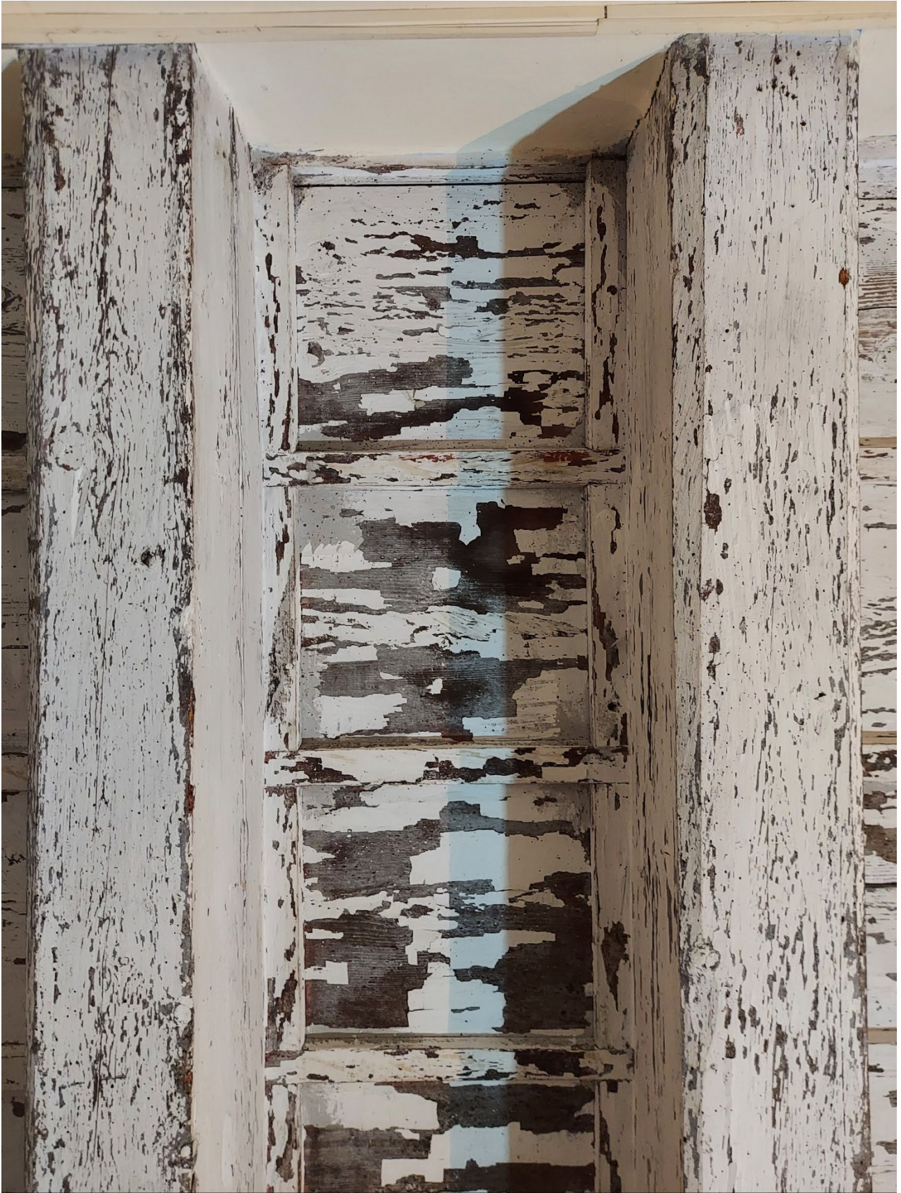
Fig.5.39 Dettaglio del solaio della sala 5b (S2). Si nota la trave principale su cui poggiano il regolo per convento ed il controregolo. Tutti gli elementi in legno del solaio sono stati dipinti di bianco.
