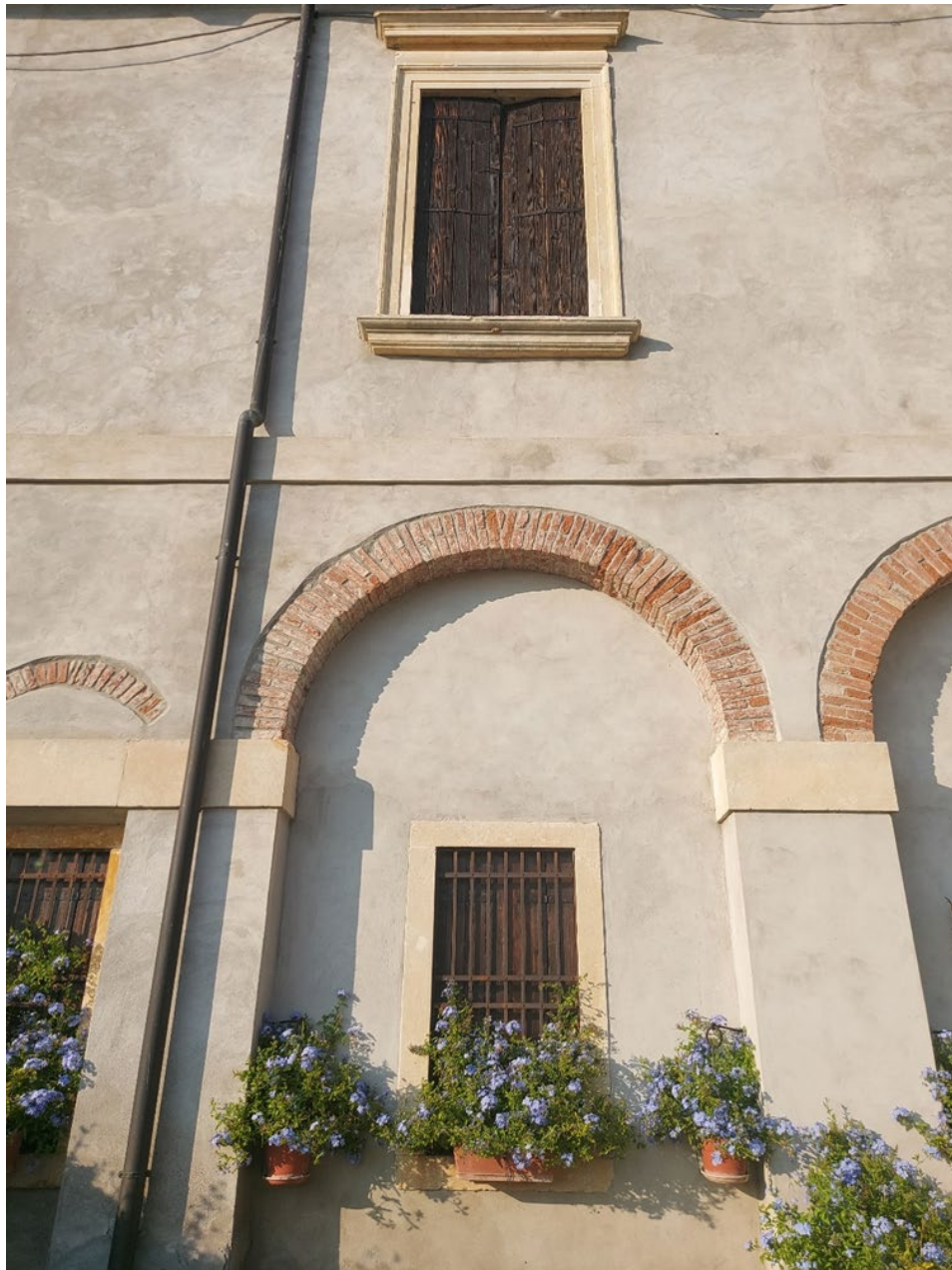
Fig.3.6 Dettaglio della loggia
