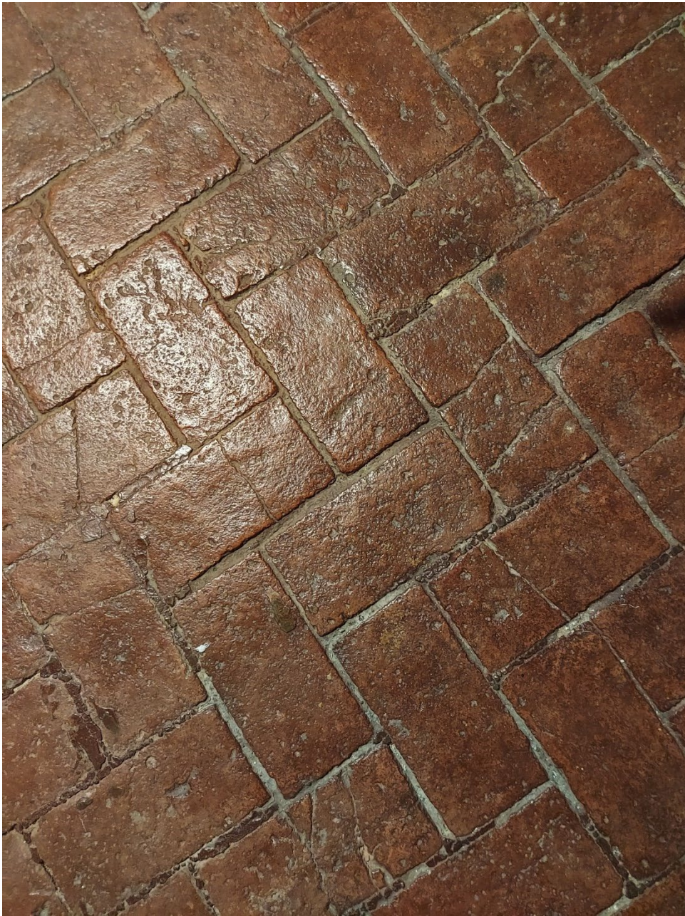
Fig.5.32 Dettaglio del pavimento della sala 6 (P4). Il pavimento è in laterizio con piastrelle rettangolari di dimensione 14x28 cm.
