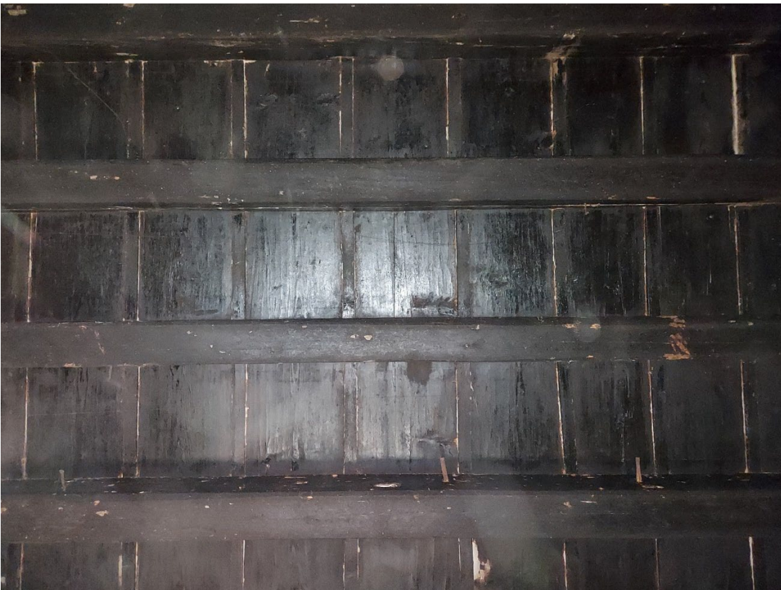
Fig.5.37 Dettaglio del solaio della sala 3 (S1).
