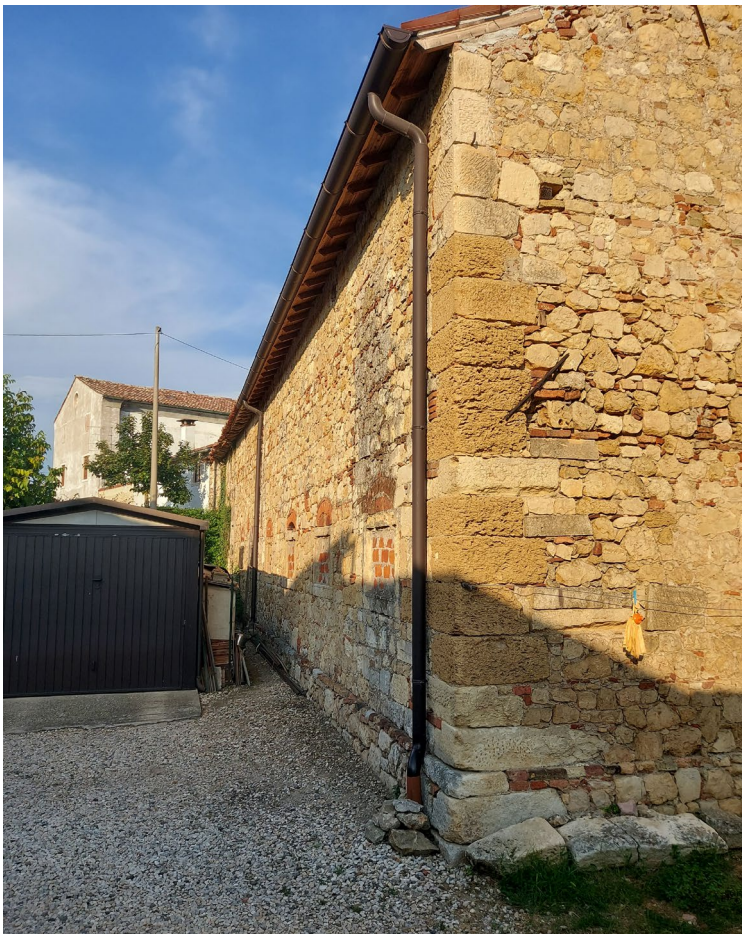
Fig.3.17 Facciata ovest della barchessa
