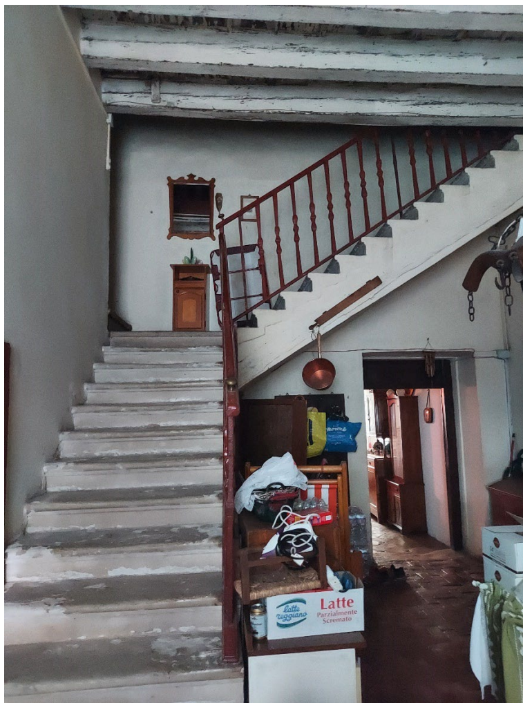
Fig.5.26 Rampa di scale in pietra nella sala 5b.
