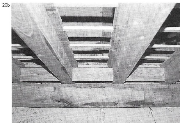
Fig.5.38 Realizzazione di un solaio a regolo per convento e controregolo (Carbonara, Trattato per il restauro 2 , pag. 137).
