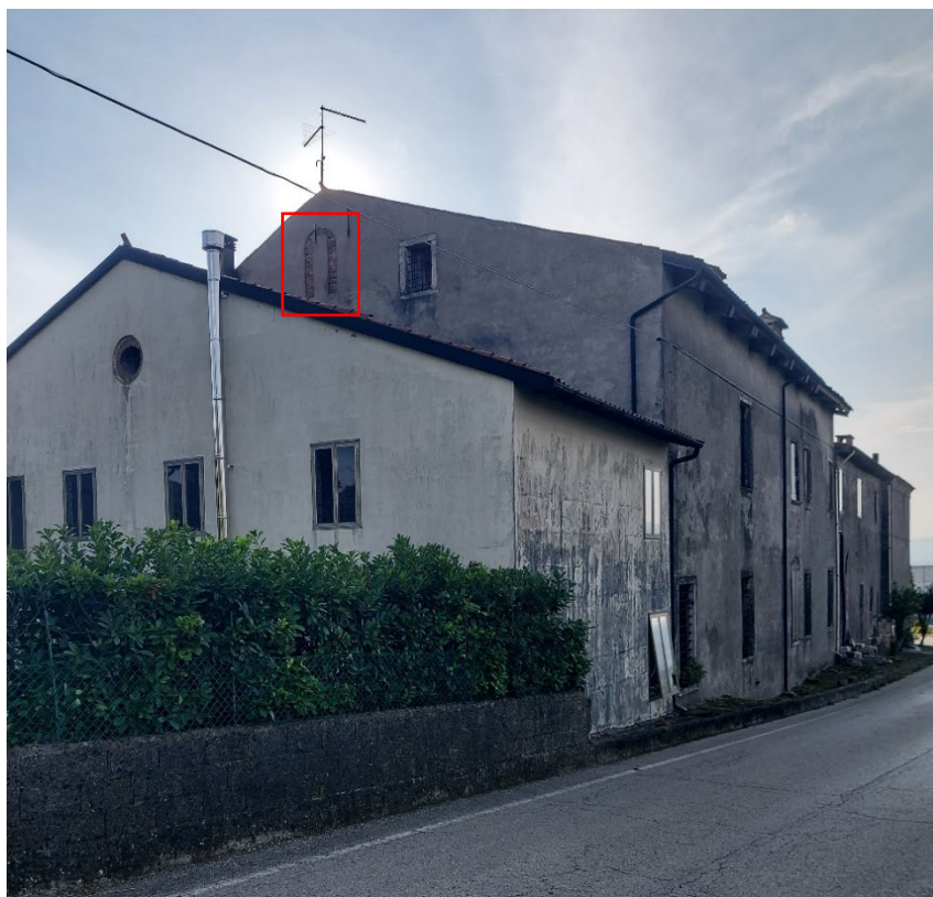
Fig. 3.12 Facciata est di Villa Arnaldi. In rosso è riquadrata l'apertura in laterizio, oggi tamponata, realizzata prima dell'intervento palladiano, a prova del fatto che il Palladio sia solo intervenuto ricostruendo una fabbrica esistente.
