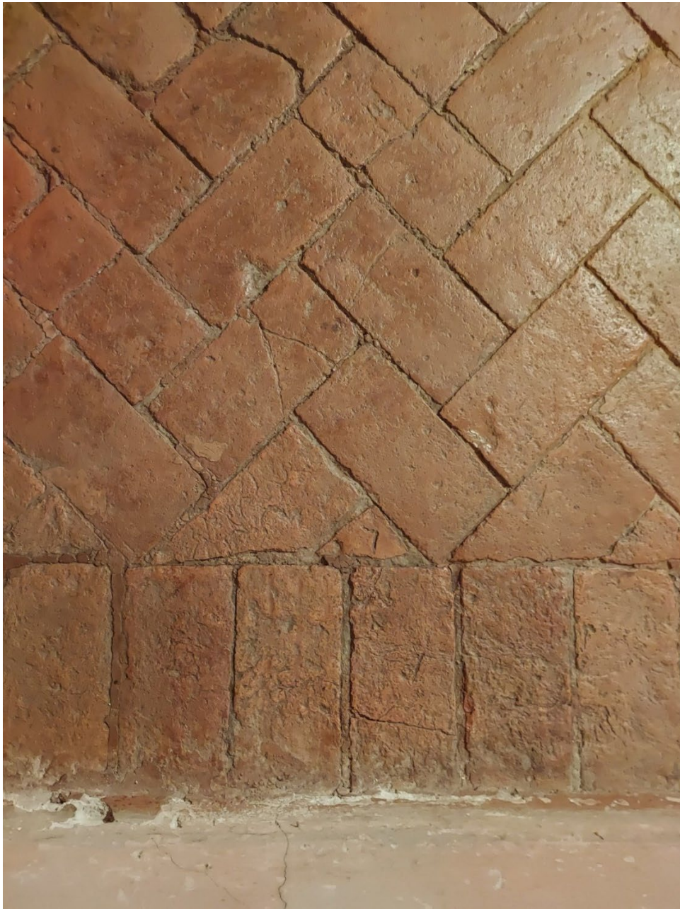
Fig.5.31 Dettaglio del pavimento della sala 4 (P3). Il pavimento è in laterizio con piastrelle rettangolari di dimensione 14x28 cm.
