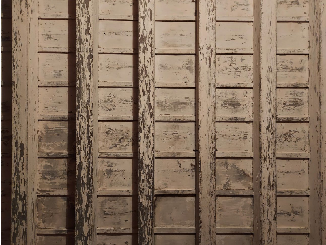
Fig.5.36 Dettaglio del solaio della sala 4 (S1).
