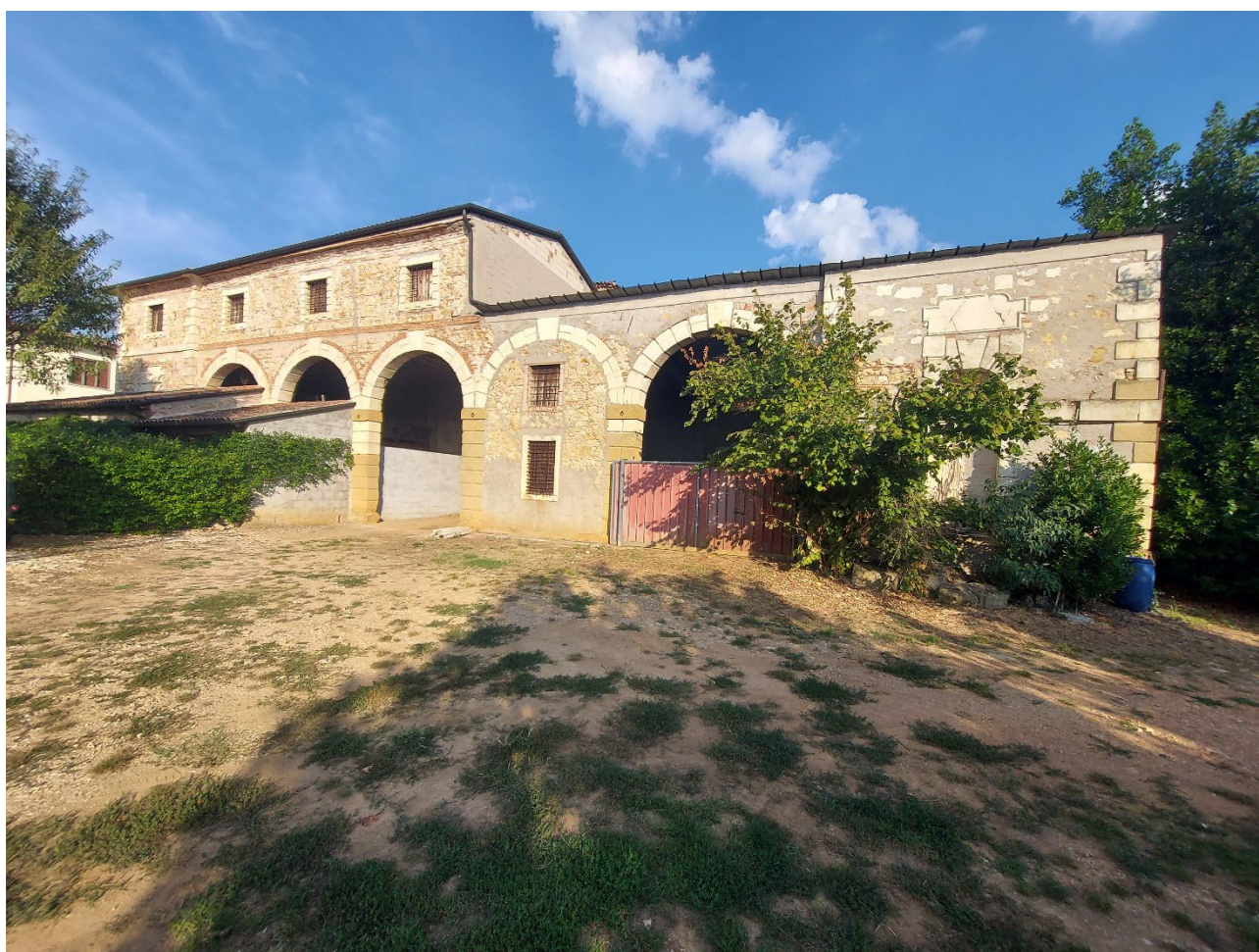
Fig.3.25 Facciata ovest della barchessa
