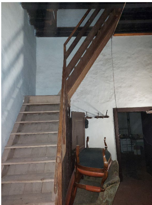
Fig.5.24 Rampa di scale in legno nella sala 3.
