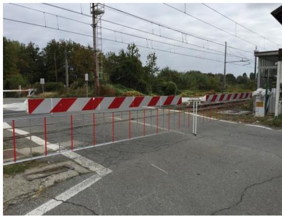
FIGURA 11 BARRIERE DI UN PL CON APPLICATI I GREMBIALI
