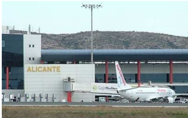
Figura 100: Aeroporto di Alicante-Elche.
