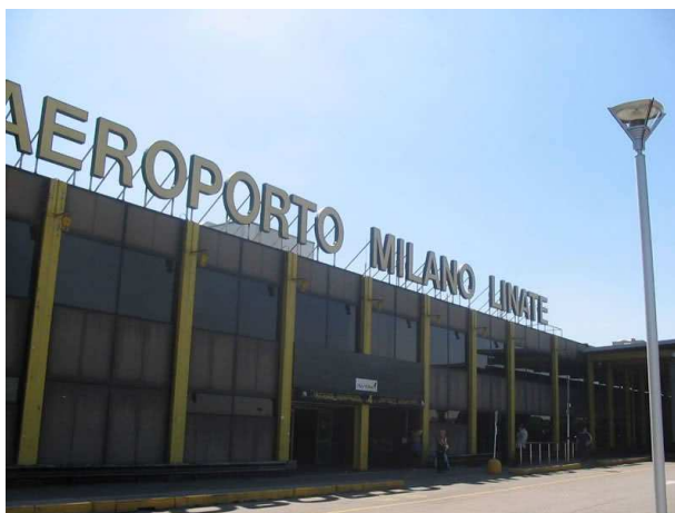
Figura 21: Termina passeggeri dell'aeroporto di Milano-Linate.
