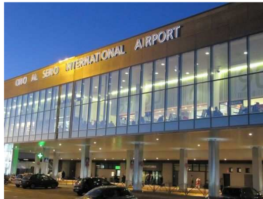
Figura 32: Terminal passeggeri dell'aeroporto di Bergamo-Orio al Serio.
