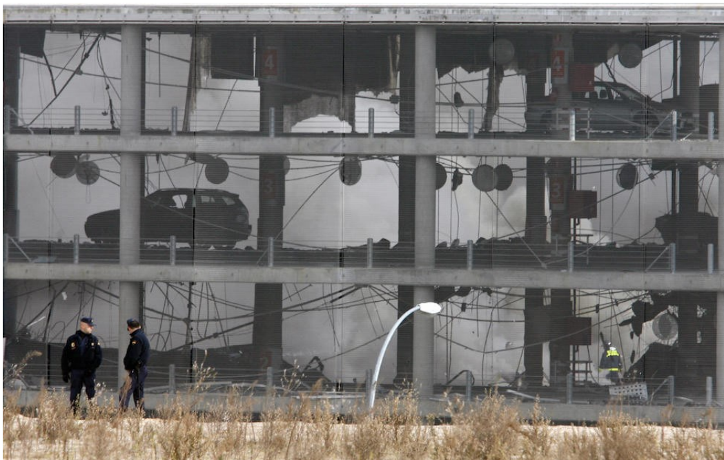
8) Il terminal 4 dell'aeroporto Madrid-Barajas dopo l'esplosione di un'autobomba, 30 dicembre 2006.
