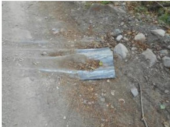
**Figura 25: canalina danneggiata dal transito di mezzi pesanti e ostruita dal materiale dello strato di usura**
