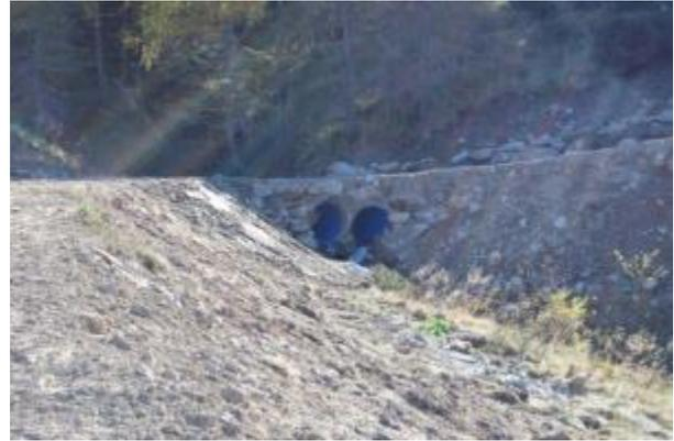
**Figura 3: sistemazione Idraulico Forestale con palificata** **Figura 4: attraversamento con sistema doppio tombotto**
