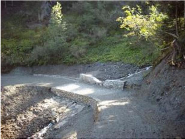
**Figura 6: opera a corda molla per la messa in sicurezza di un guado**
