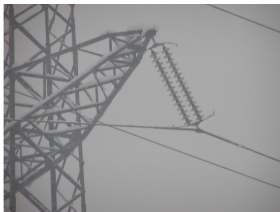
Figura 2.1.7: Esempio cedimento sostegno dell'isolatore
