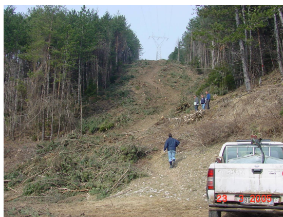
Figura 3.4.10: Esempio pulizia fascia rispetto
