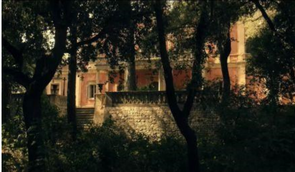
Figura 30 Inquadratura della casa dall'esterno
