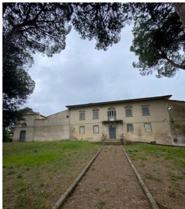
Fig. 201 Villa Bandini, Poggio Piano, Gabbro (LI), 2023
