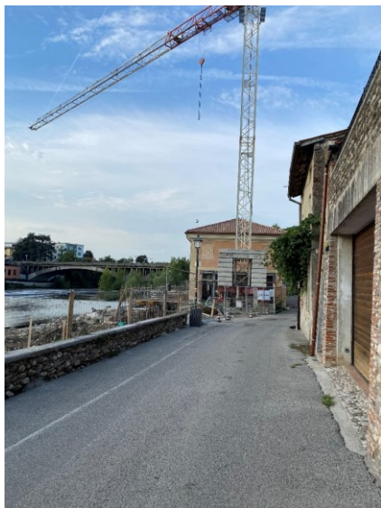
Figura 27: Via Macello, in destra idrografica.
