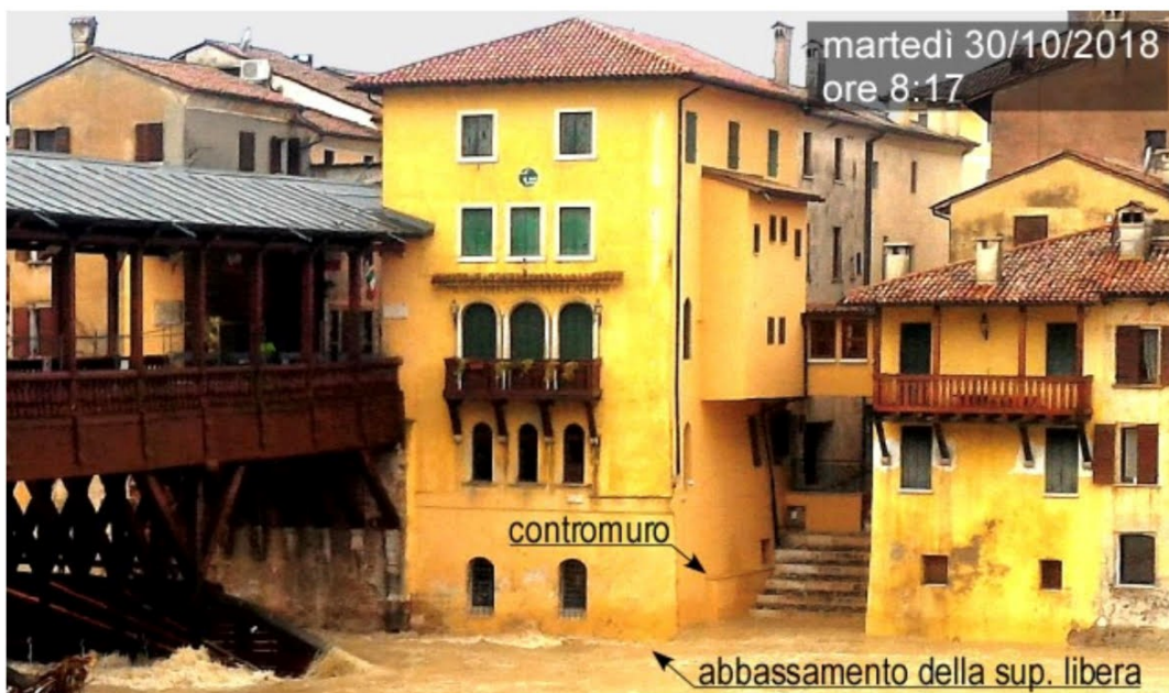
Figura 19: Fiume Brenta il giorno 30/10/2018 alle ore 8.17: l'immagine ritrae gli edifici situati in destra idrografica, a monte del Ponte degli Alpini.
