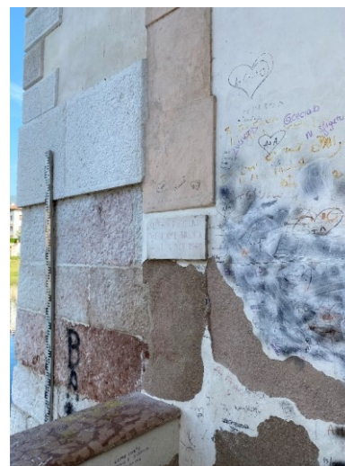
Figura 9: lapide marmorea infissa nel muro di Palazzo Sturm, in sinistra idrografica. A sinistra si può notare anche un'asta idrometrica, utilizzata in passato per la misura del livello del Fiume Brenta.
