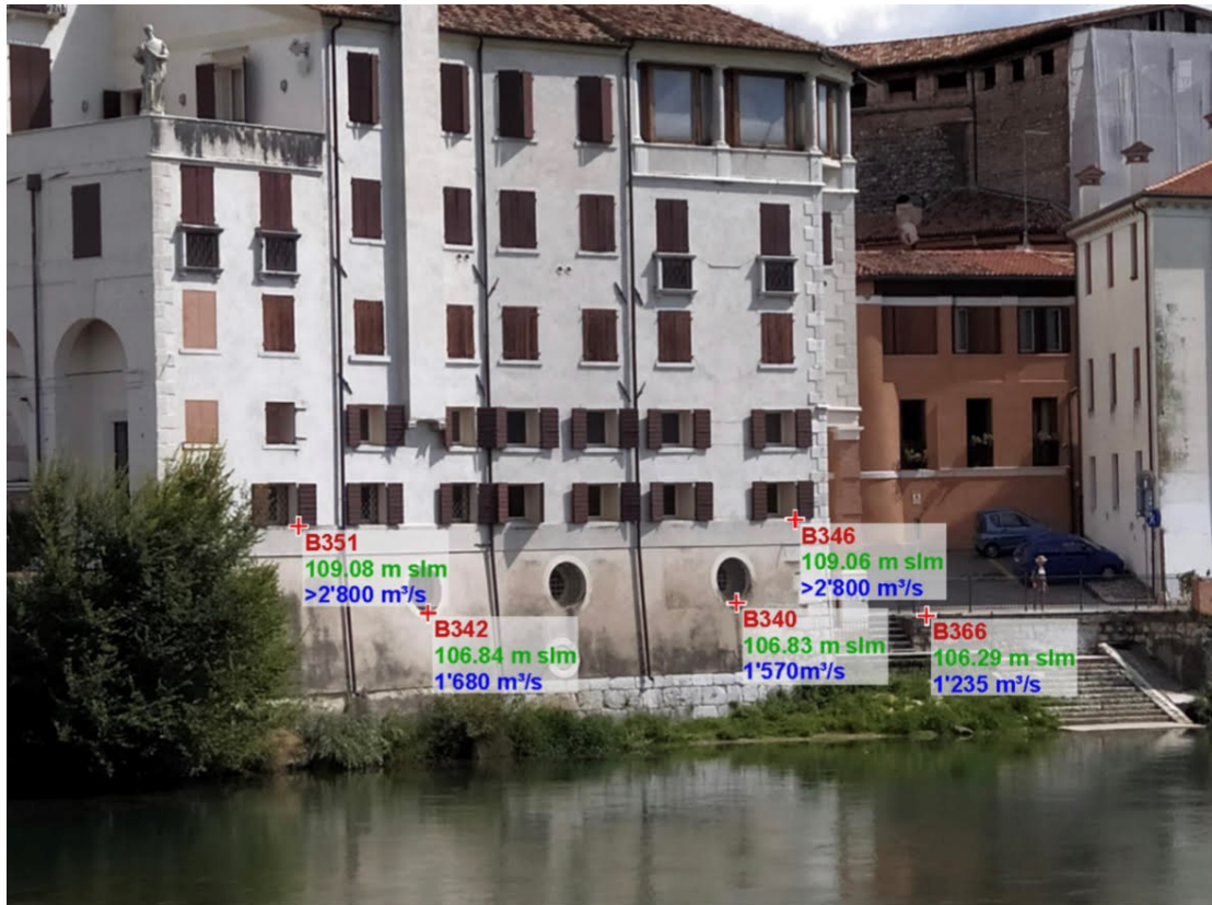
Figura 27: la foto riporta la facciata di Palazzo Sturm, in sinistra idrografica. Si vedono le quote delle finestre ottenute dal rilievo di Agosto 2020 (colore rosso), la quota rispetto al medio mare (in verde), e il valore di portata che, secondo il modello idrodinamico, porta al raggiungimento di tale livello. Questo è un esempio di applicazione combinata di rilievo topografico e dati ottenuti dal modello.
