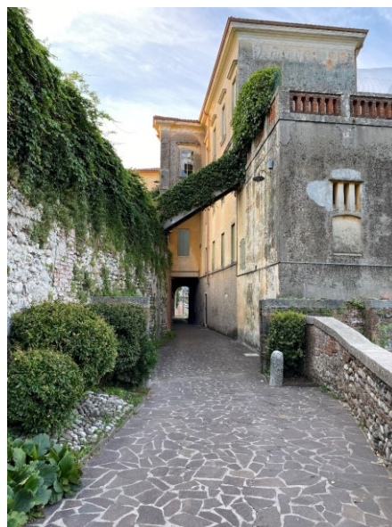
Figura 26: accesso privato di Via Pusterla, in sinistra idrografica.
