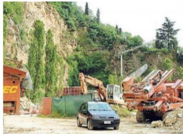
Il sequestro del cantiere dell'ascensore della Rocca: era il maggio 2008
