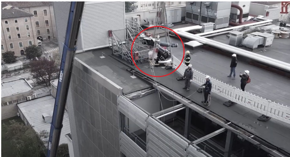
Figura 3.16: angiografo calato per mezzo di una gru [34].
