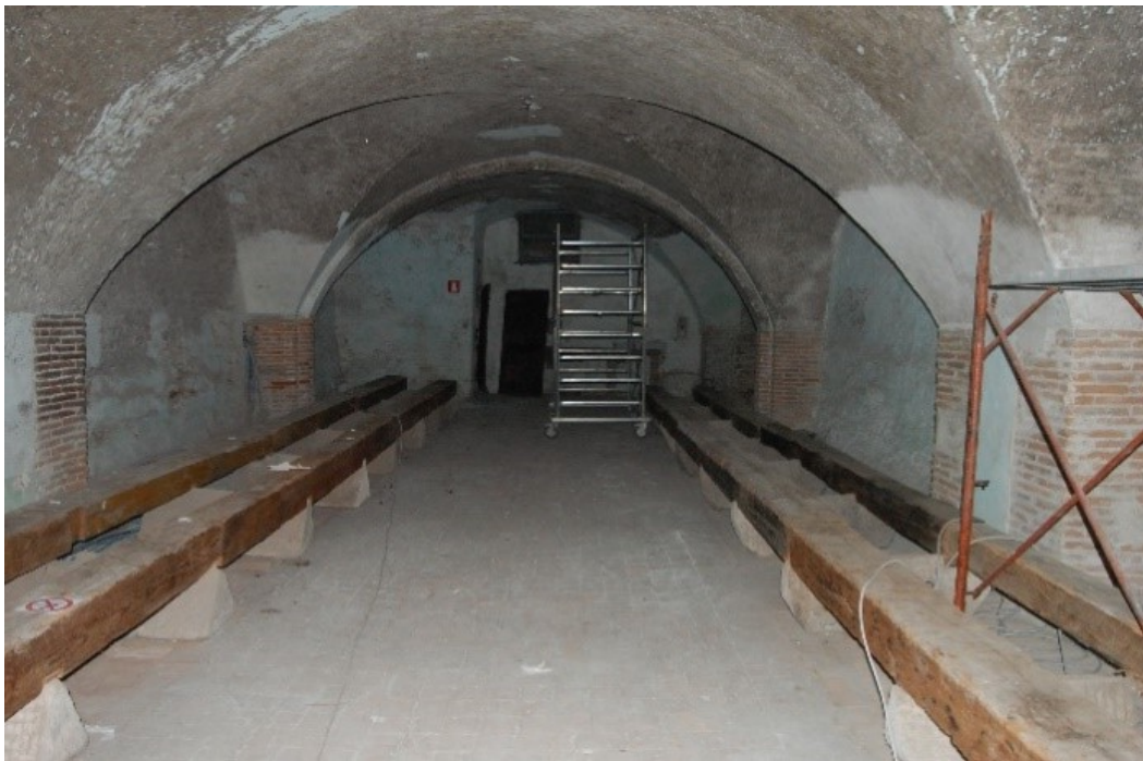
Fig. 1.9a Tre fasi di allestimento della nuova galleria nel 2008 (foto di Riccardo Capineri)
