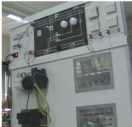
Figura 5.1: Vista general del panel
