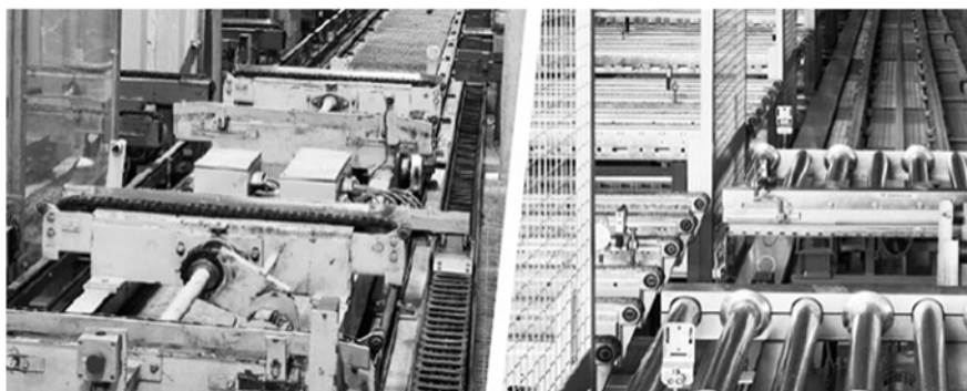
Figura 13 - Una foto tratta dal web relativa al revamping di una linea di movimentazione di casse in legno per imballaggi (tratta dal web)
