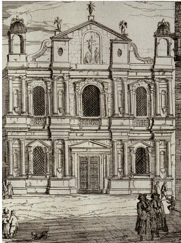
Figura 24 Stampa intitolata "Facciata della Scuola di San Fantino" (Carlevarijs, Fabbriche e Vedute di Venezia, 1703)
