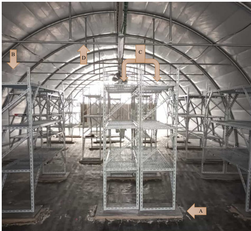
Figura 9 - Interno della fungaia A) Lastre in cemento su cui sono fissati gli scaffali; B) Scaffale singolo; C) Scaffale doppio; D) Sistema di raffreddamento passivo, micro-sprinkler.
