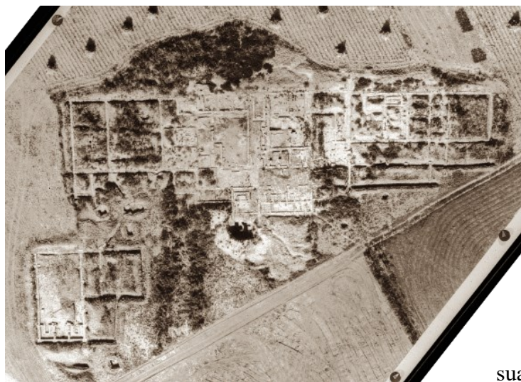
Figura 18: Fotografia zenitale realizzata durante lo scavo del secolo scorso presso la villa di Villabartolomea, località Venezia Nuova.
