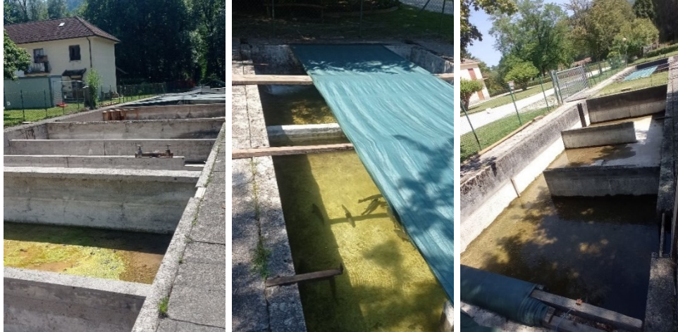
Figura 14: a sinistra, vasche in fase di modernizzazione (Bresolin Riccardo). Figura 15: in centro, vasche con adulti di trota fario (Bresolin Riccardo). Figura 16: a destra, particolare struttura di alcune vasche non utilizzate (Bresolin Riccardo).
