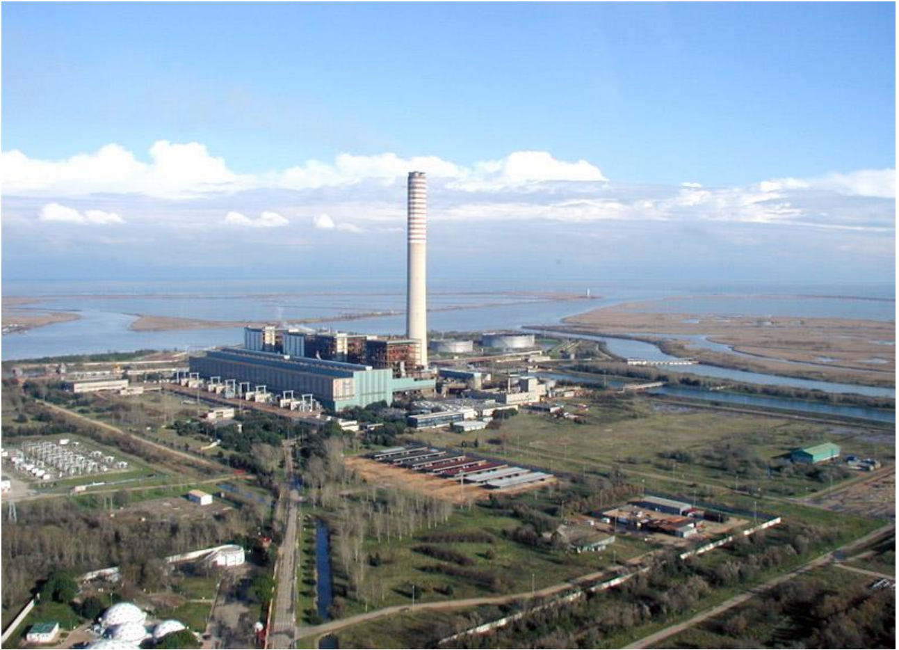
Veduta aerea della Centrale Termoelettrica di Porto Tolle, in provincia di Rovigo Immagine tratta da www.informazioneconsostenibile.info
