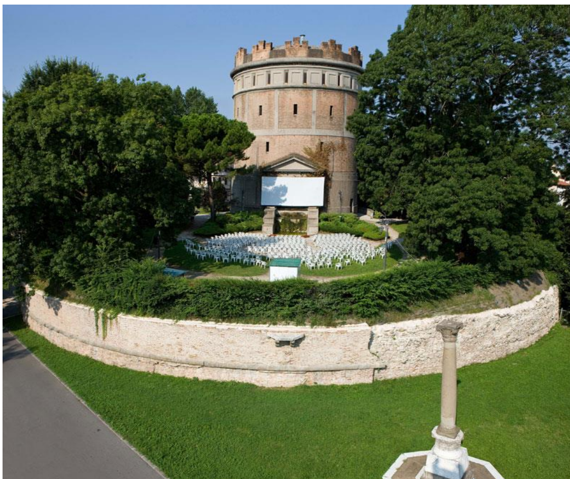
Una veduta della Rotonda, la prima Centrale dell'acquedotto costruita a Padova negli anni '20 in via Codalunga
