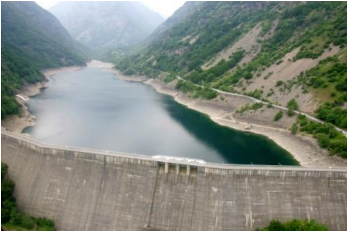
Una veduta suggestiva della diga della centrale idroelettrica Luigi Einaudi, costruita ad Entracque, in provincia di Cuneo.
