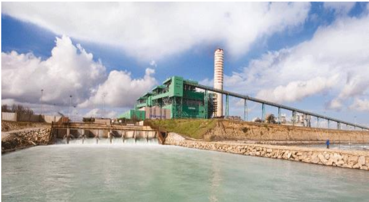
Una veduta da terra della centrale termoelettrica Federico II, edificata a Brindisi
