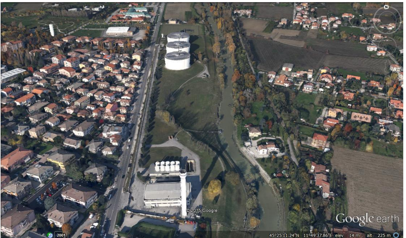
Il Centro Idrico Brentelle. Sullo sfondo i tre enormi serbatoi da 25 milioni di litri ciascuno Immagine tratta da Google Earth in data 5/5/2015
