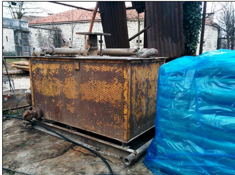
Figura 4.5 – Vasca di preparazione del fango di perforazione bentonitico, dotata di una capacità di 2 m 3 .
