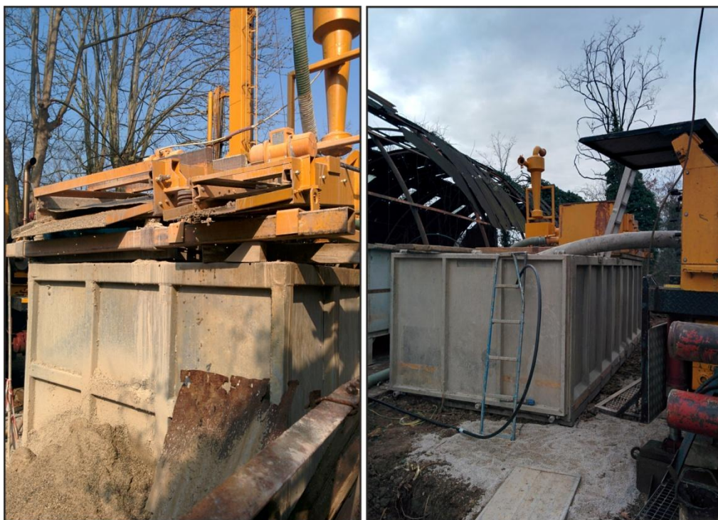
Figura 4.4 – Vibrovaglio (a sinistra) e vasca di raccolta dei fanghi di perforazione (a destra) presenti in cantiere.
