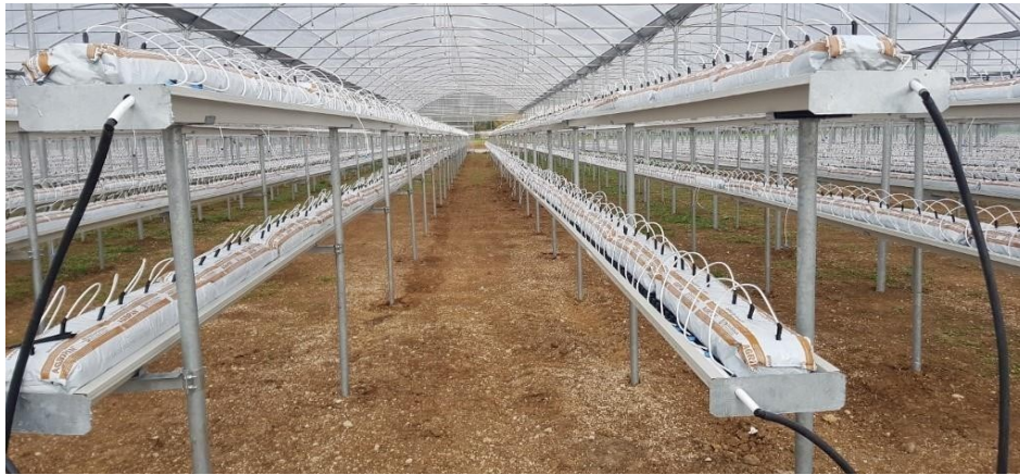
Figura 25 Illustrazione della messa in opera di un sistema a contenitori di substrato a doppio livello.
