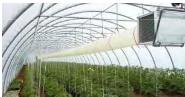
Figura 59 Aeroterma a servizio della serra.
