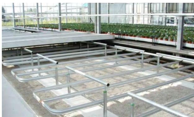
Figura 61 Predisposizione dell'impianto di riscaldamento dei bancali
