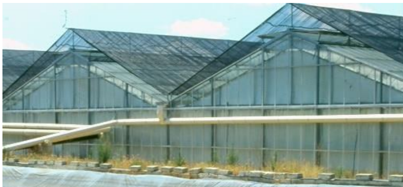
Figura 40 Ombreggiamento di una serra ottenuto con reti posizionate esternamente.
