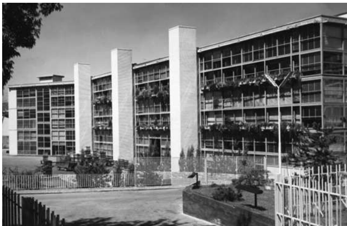
Fig. 17: Edificio della Nuova ICO (1956-1958). In primo piano le torri per gli impianti, rivestite da maioliche gialle.
