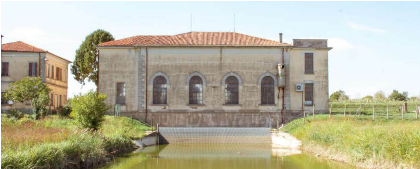
Foto in alto a sinistra: Idrovora del Termine, fonte: https://www.festivalbonifica.it/2018/idrovore-aperte/ Foto in alto a destra: Idrovora Cà Corniani, 2022, fonte: https://www.cacorniani.it/ Foto in basso: Idrovora Sindacale (Comune di Concordia Saggitaria)
