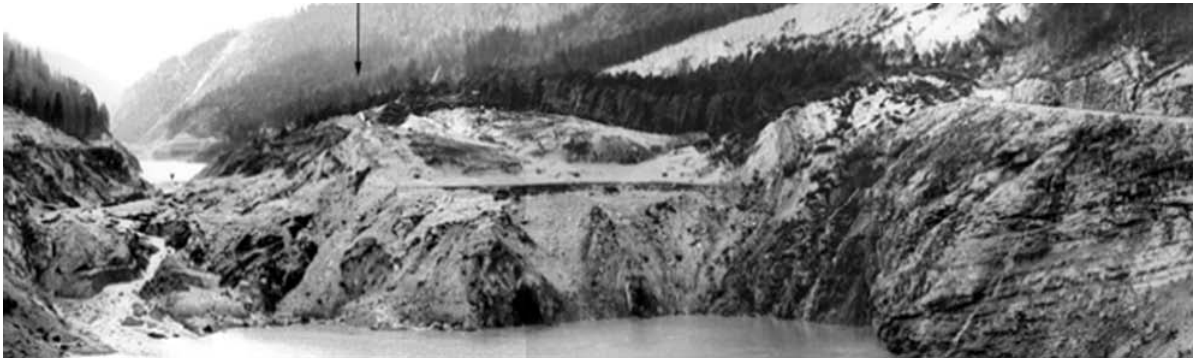
Figura 1.4: Frana di Pontesei.
