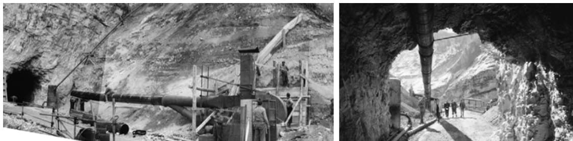
Figura 1.7: Costruzione della galleria di sorpasso lungo la sponda destra del bacino del Vajont.
