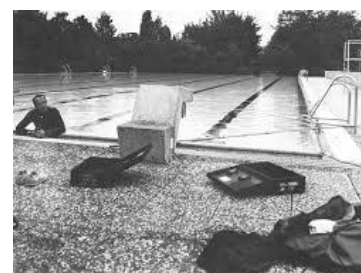
Fig. 256: Installazione di apparecchiature tecnologiche in una piscina per il progetto "Listen" di Neuhaus
