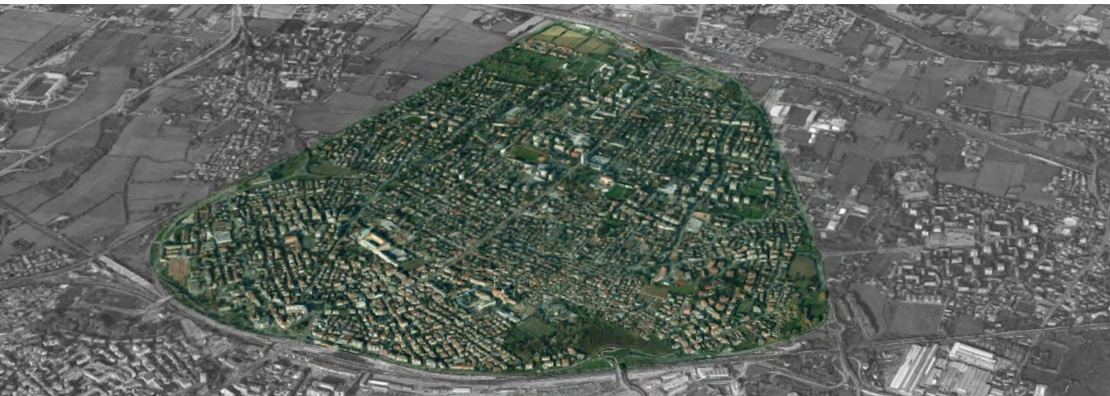
Fig. 246: Vista aerea della "punta" del quartiere Arcella
