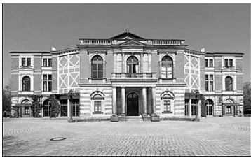
Fig. 75: Facciata d'ingresso del teatro di Bayreuth, definita adatta ad una stazione di provincia
