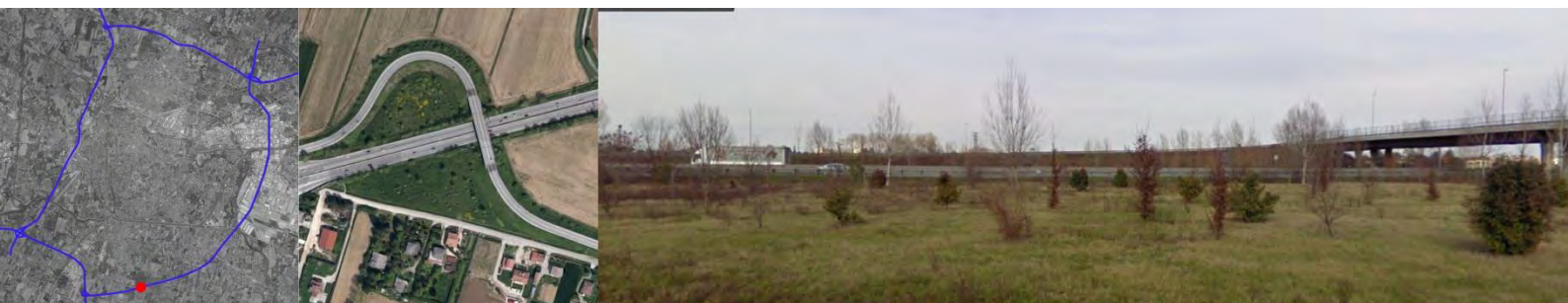
Fig. 254: Cavalcavia di Salboro. Interstizio tra la tangenziale, l'abitato, lo svincolo ed il cavalcavia.
