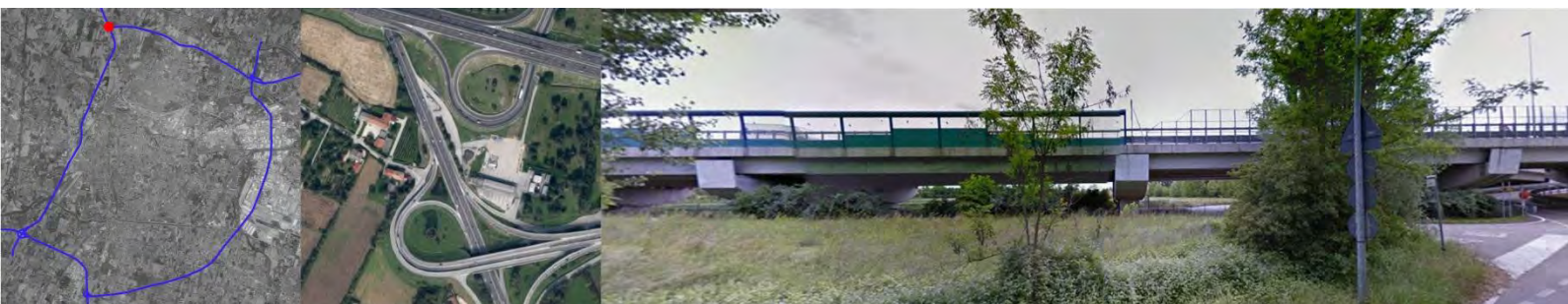
Fig. 250: Nodo di intersezione tra la tangenziale ovest, tangenziale nord e l'autostrada. Interstizio tra gli svincoli.
