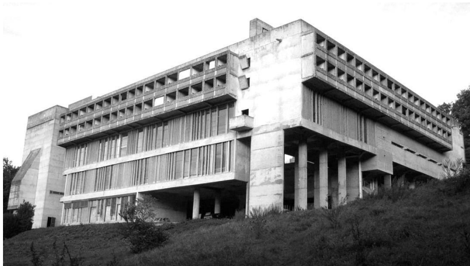
Fig. 111: Le Corbusier, Xenakis, Convento di Santa Maria de La Tourette. La ripartizione delle vetrate sono frutto degli studi matematici e musicali di Xenakis
