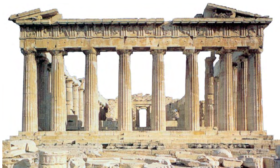
Fig. 144: Fotografia utilizzata per il rilievo della facciata
