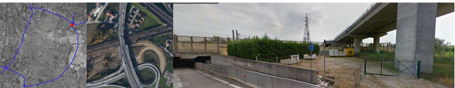
Fig. 255: Nodo di Ponte di Brenta. Interstizio tra ferrovia, autostrada, tangenziale nord, tangenziale est e abitato.
