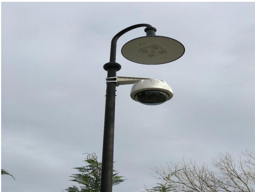
*Figura 26 - Lampade adattive installate nel Lungargine Scaricatore, questa nel particolare dotata di telecamera*
