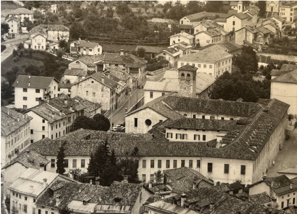
Fig. 44. Feltre, Borgo Ruga, veduta aerea del complesso di Ognissanti negli anni 70 del XX secolo.
