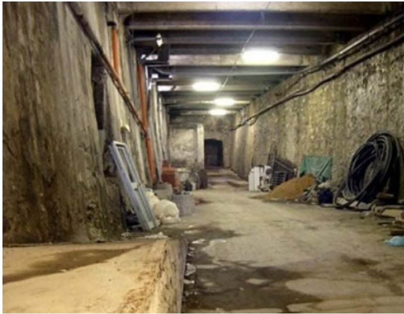
Fig.1.6 - Galleria stradale, Genova. SSI, 2016
