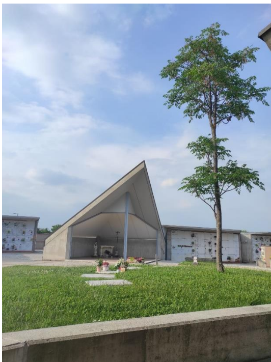
Fig. 1.2 – Fotografia scattata nel cimitero di Torri di Quartesolo (VI) del campo dedicato alla sepoltura dei feti.
