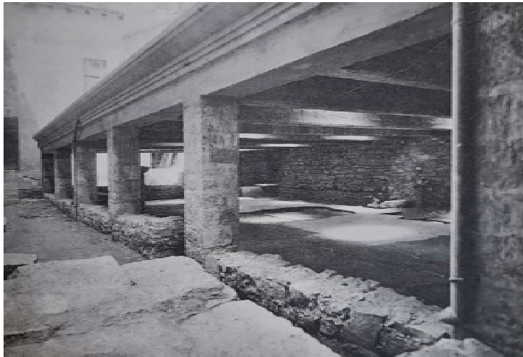
63. Parenzo, l'area archeologica a nord della basilica: la "tettoia" di protezione dei pavimenti musivi costituita da un solaio di cemento armato (Trieste, Archivio della Soprintendenza Archeologica, Belle Arti e Paesaggio del Friuli Venezia Giulia, Archivio fotografico n. 3510) da "Ferdinando Forlati e la basilica Eufrasiana di Parenzo. Criteri e metodi di restauro (1926-1935)" ne "La conservazione dei Monumenti a Trieste, in Istria e in Dalmazia (1850-1950)" L. Caburlotto, R. Fabiani, G. Perusini
