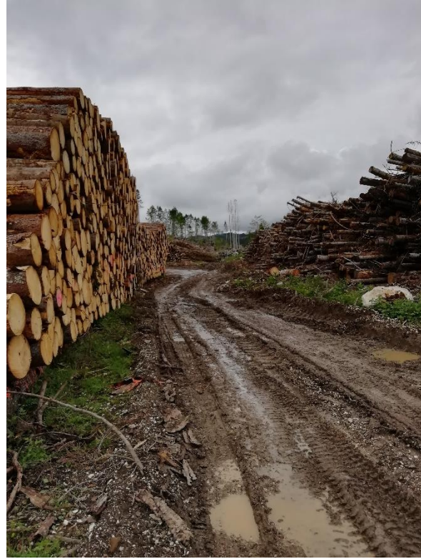
Figura 2.1.1.5: effetto del passaggio del forwarder di MM Forest OÜ sulla strada forestale di Dragonade - giugno 2020
