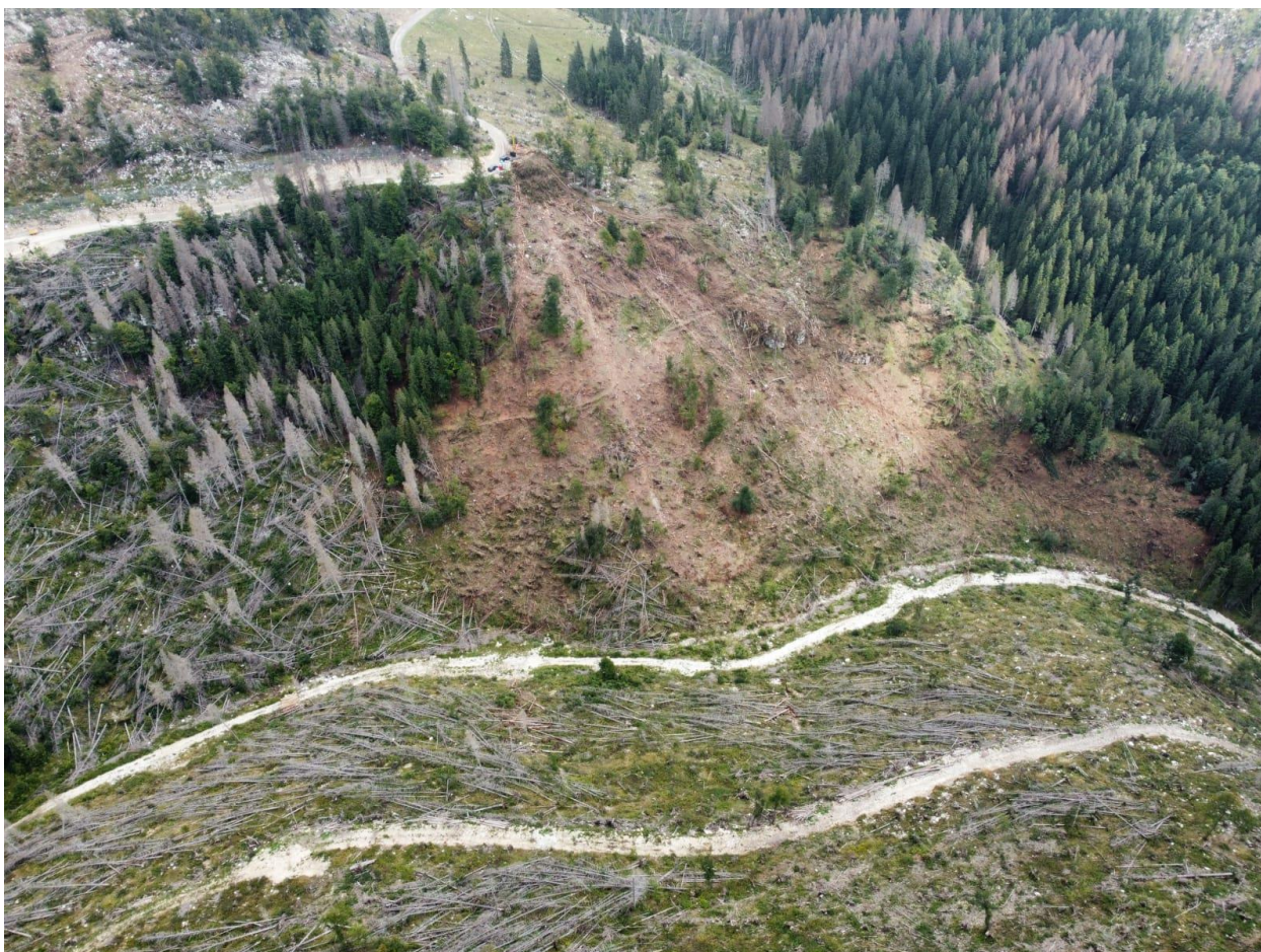
Figura 2.12.1.3: sono visibili le linee di esbosco della gru a cavo presso il lotto Strada Brustolade – agosto 2022
