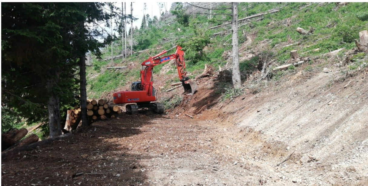
Figura 2.4.4: allargamento del sentiero dei Cippi presso il lotto Conca per la sistemazione della gru a cavo della Figura 2.1.1.10
