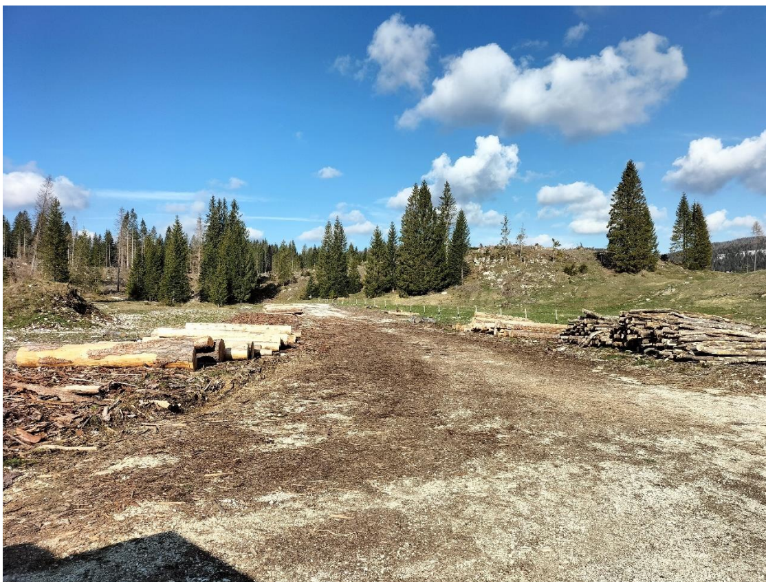
Figura 2.5.5: piazzale realizzato dall'allargamento della strada della Figura 2.5.4
