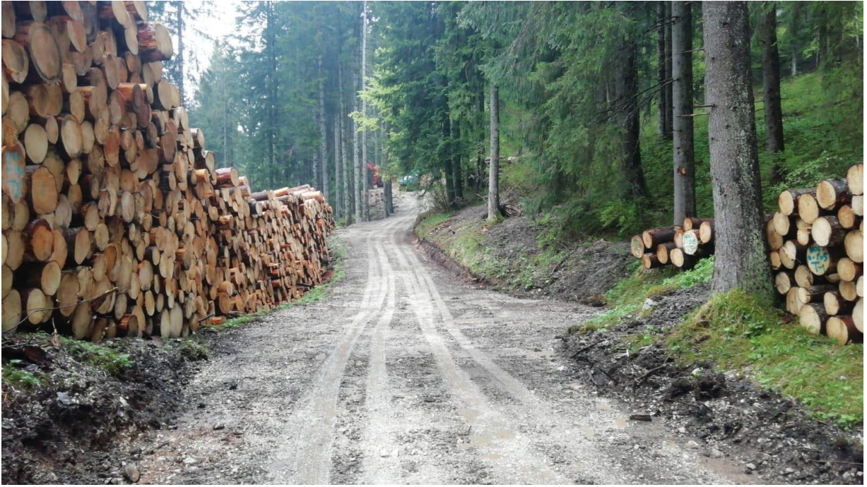
Figura 2.4.5: sistemazione e allargamento della Strada Borata. Da notare la differenza con la Figura 2.4.3, che raffigura la stessa strada prima delle sistemazioni
