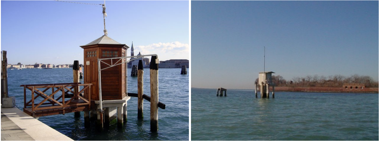
Figura 4.1: A sinistra: stazione con pozzetto di calma presso Punta della Salute. A destra: stazione con pozzetto di calma a San Giorgio in Alga. Fonte: ISPRA.
